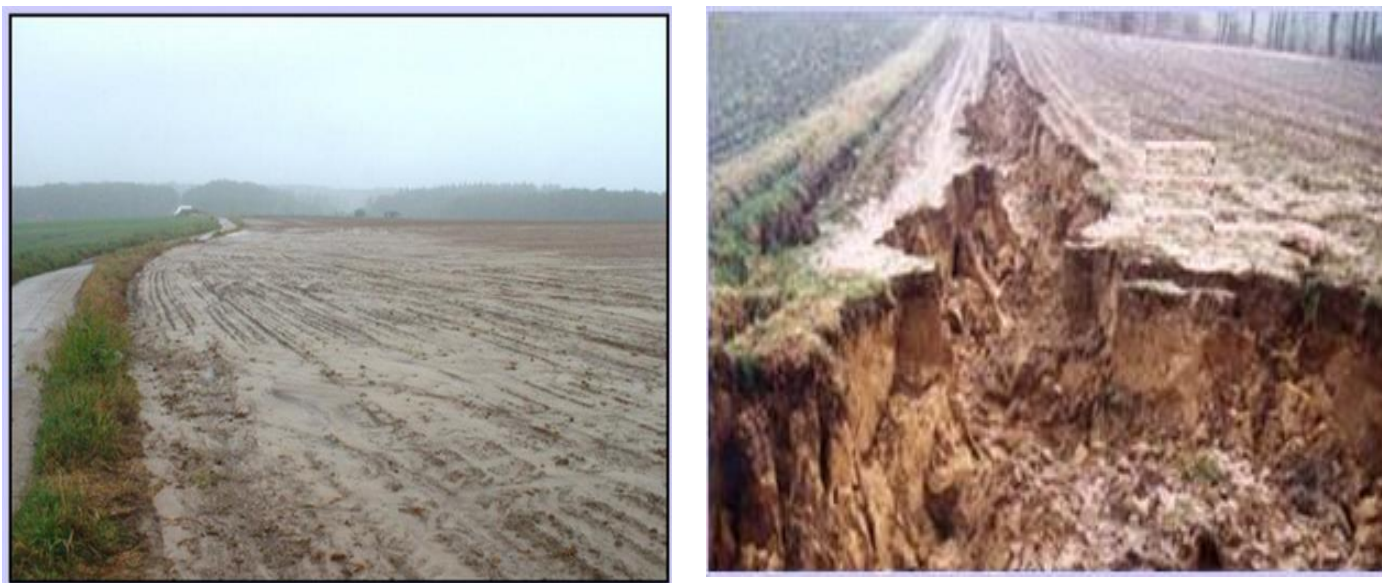
Figure I.1: Exemple d'érosion en nappe et par rigoles
