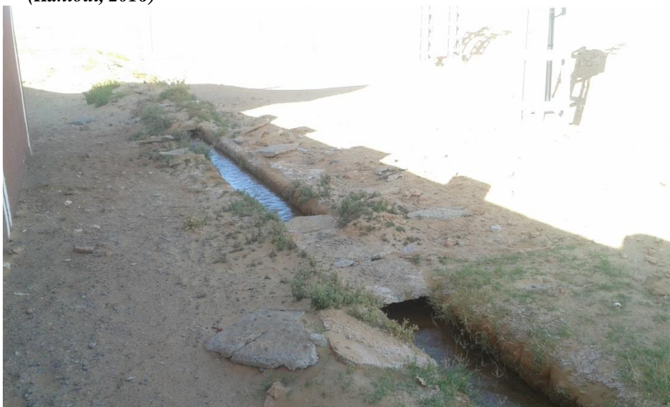
Fig. III.13. Seguia principale d'une foggara de l'oasis d'Admer (Kantaoui, 2016)
