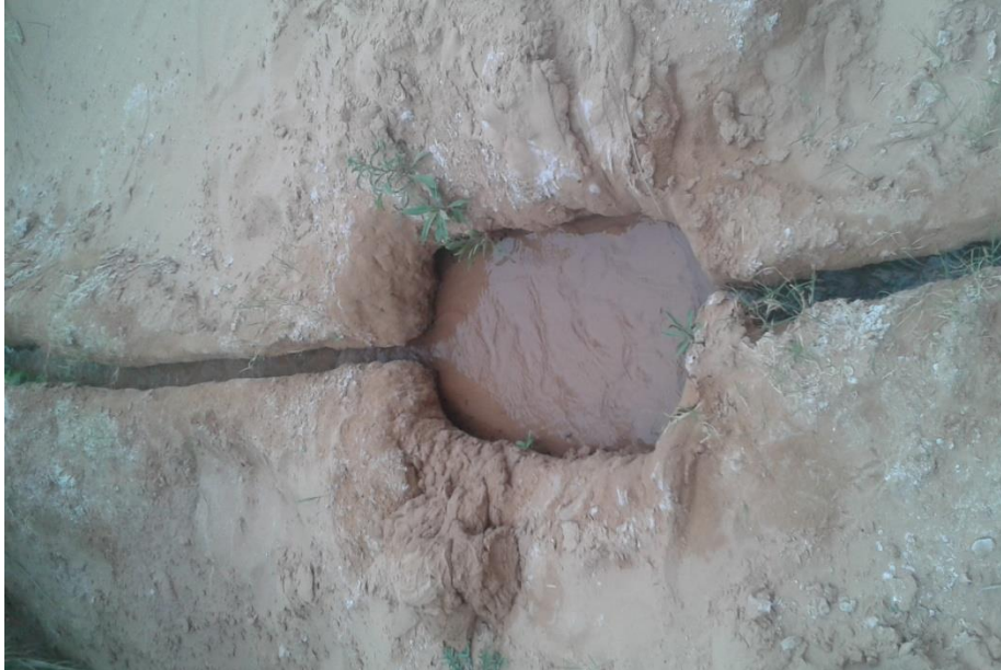
Fig. III.20. Bassin de décantation dans le réseau de distribution D'une foggara de l'oasis de Tabrkant (kantaoui, 2016)
