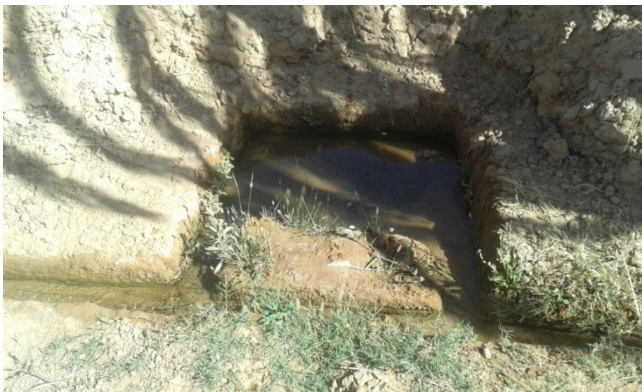
Fig. III.21. Bassin de décantation dans le réseau d'irrigation d'une foggara Dans l'oasis de Bour de Zaouiet Kounta (kantaoui, 2016)
