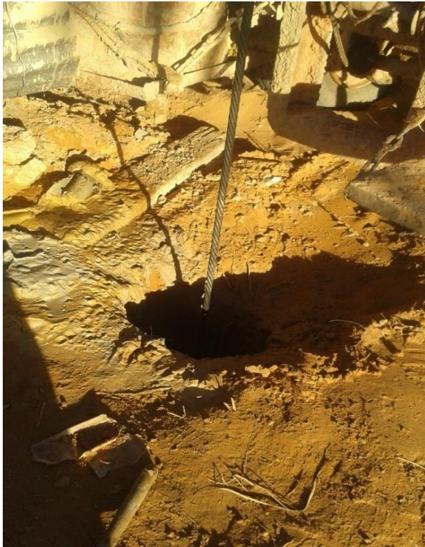
a) Forage d'une profondeur de 60 m
