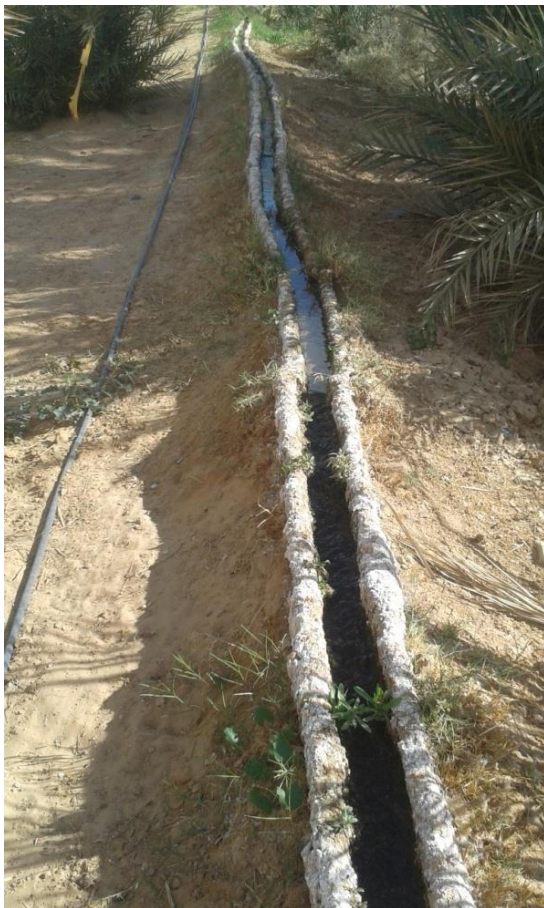
Fig .III.15. Seguia Tertiaire d'une foggara de Zaouiet Kounta (Kantaoui, 2016)
