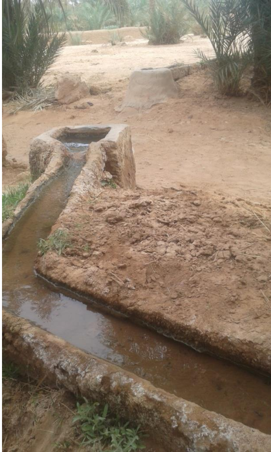
Fig. 3.22. Tube en U dans le réseau d'irrigation Dans l'oasis dz Zaglo de Zaouiet Kounta (kantaoui, 2016)
