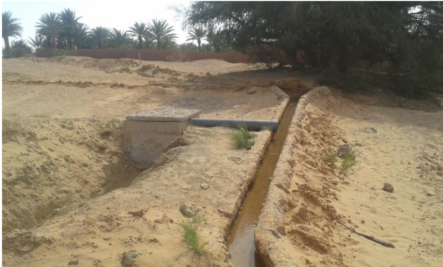
Fig.IV.3. Raccordement d'un forage dans la seguia de la foggara de Bouzegdad(kantaoui, 2016)
