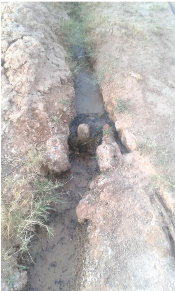
Fig.3.17. Kasria tertiaire d'une foggara de l'oasis Zaouiet Kounta (kantaoui, 2016)
