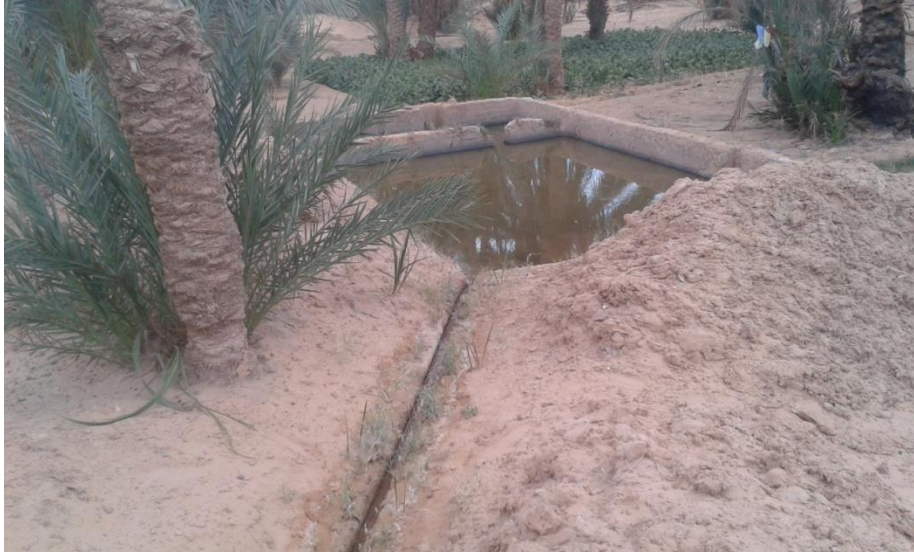
Fig. 3.16. Madjen d'une foggara dans l'oasis de Zaouiet Kounta (kantaoui, 2016)
