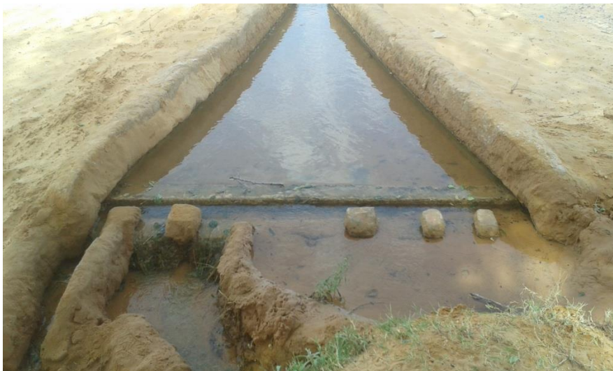
Fig. IV.4. Kasria Lakbira de la foggara de Bouzegdad renforcée Par un forage(kantaoui, 2016)
