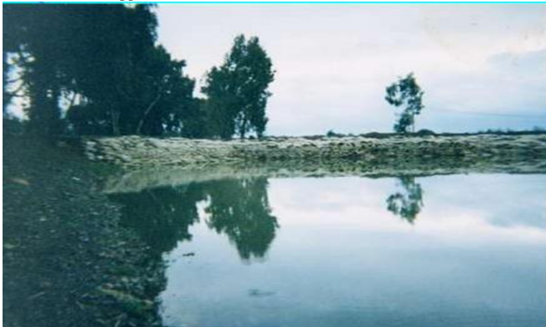
Figure IV.5: vue amont de la retenue en BIG-BAG
