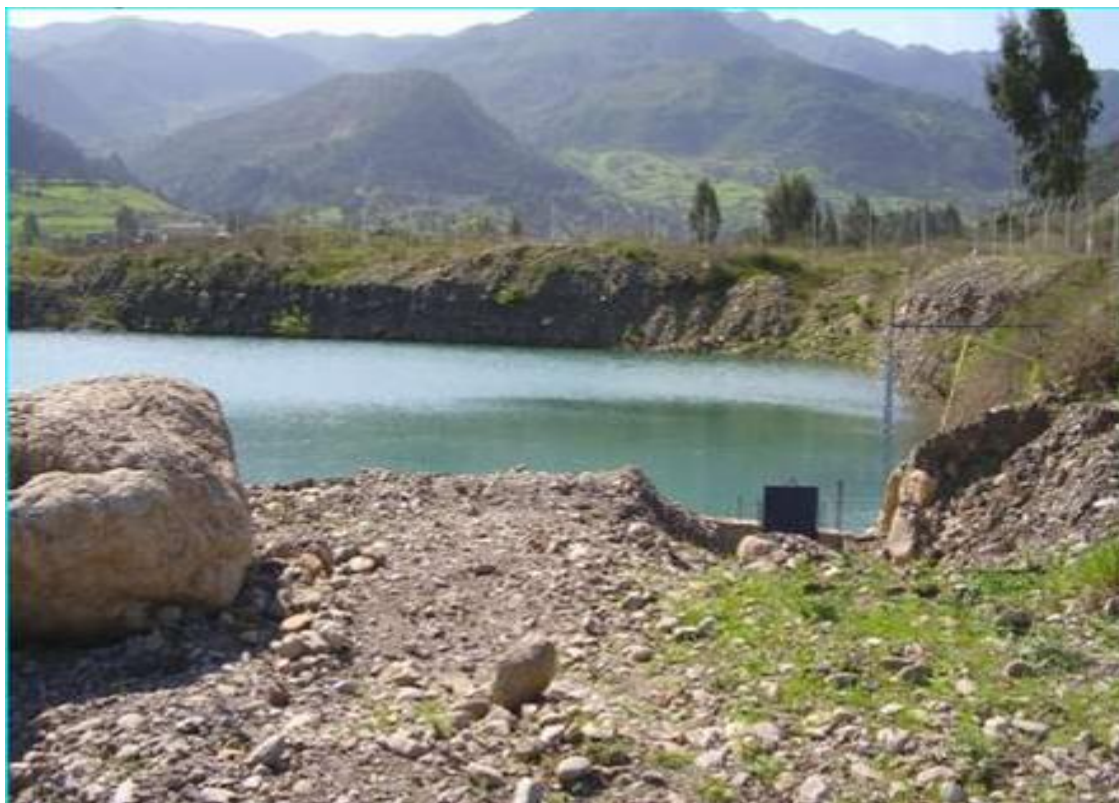
Figure IV.7: bassin de décantation du système ANRH avec vue d'une partie du bassin versant
