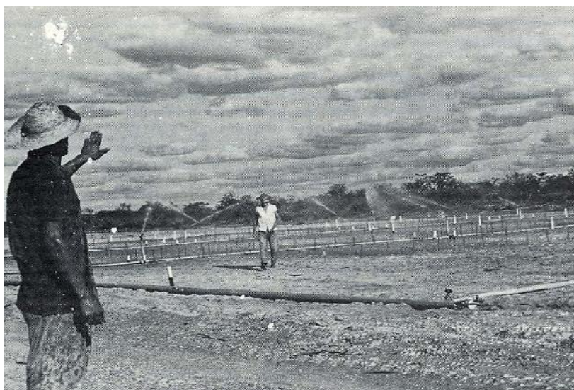
Figure II-8 Schéma type d'un réseau d'irrigation par aspersion
