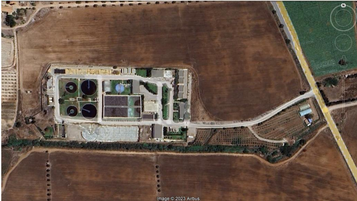
Figure III.2 : Vue aérienne de la station d'épuration d'Ain Témouchent(Google Earth, 2023)
