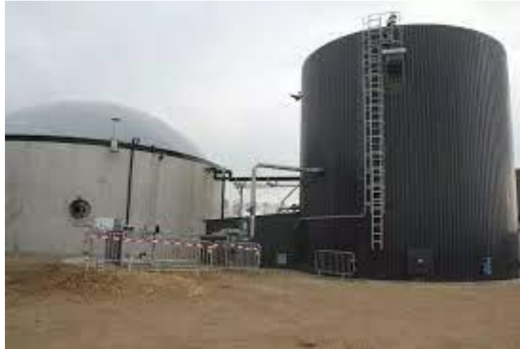
FigureII.15 : l'ouvrage de la méthanisation.
