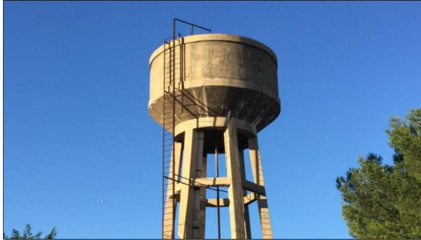
Figure I-10 : Cuve d'un réservoir d'AEP en béton (Source : https://etancheite.arcane-industries.fr/details-peinture+epoxy+pour+citerne+et+reservoir+d+eau+potable+repepoxy+ep-227.html )
