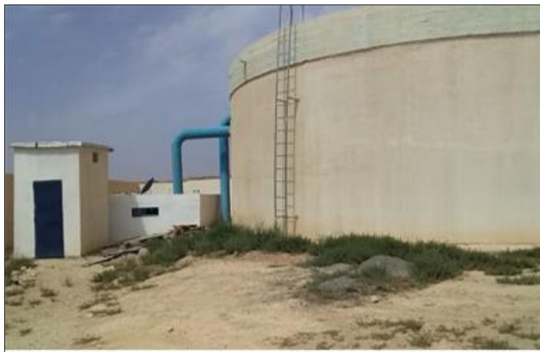
Figure I-2 : Réservoir RAS EL MA (Source : photographie personnelle)
