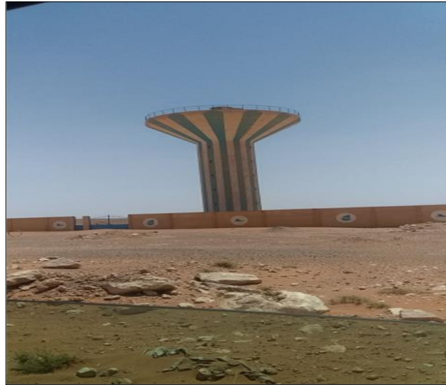
Figure I-3 : Château d'eau régulateur de débit TOUIL-ABD EL MOULA (Source : photographie personnelle)
