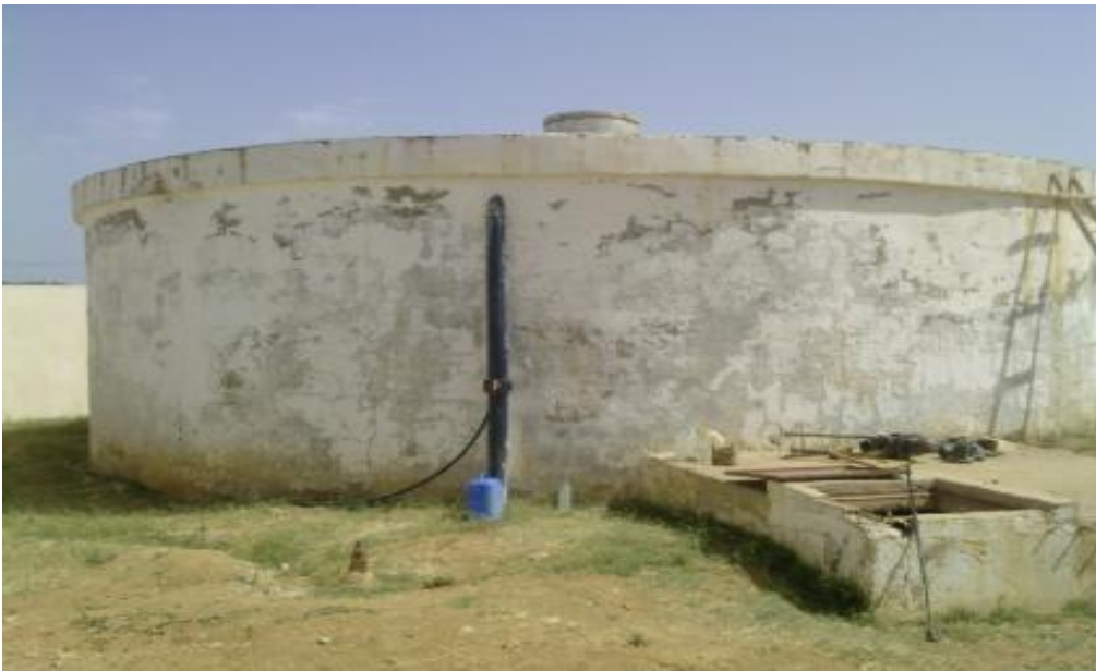
Figure.II.1. Réservoir R 500 m 3 (DRE Médéa).
