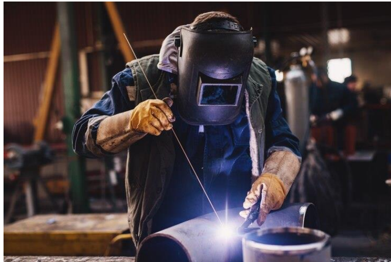
Figure.I.10:Photo de soudure des conduites [23]
