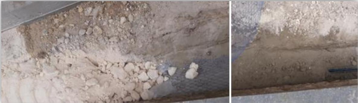
**Figure VII. :** Pose des canalisations en tranchée ouverte.
