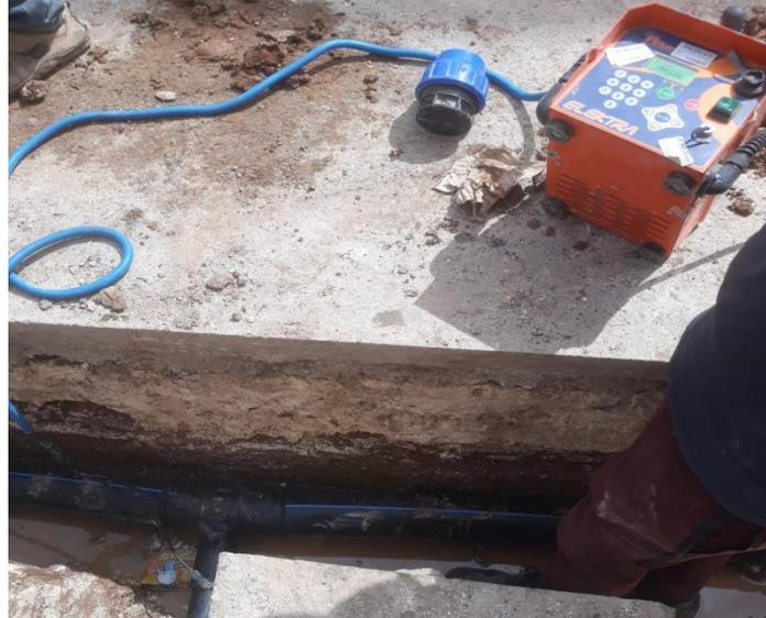
**Figure VII. 5:** Mise en Œuvre d'assemblage par fusion.
