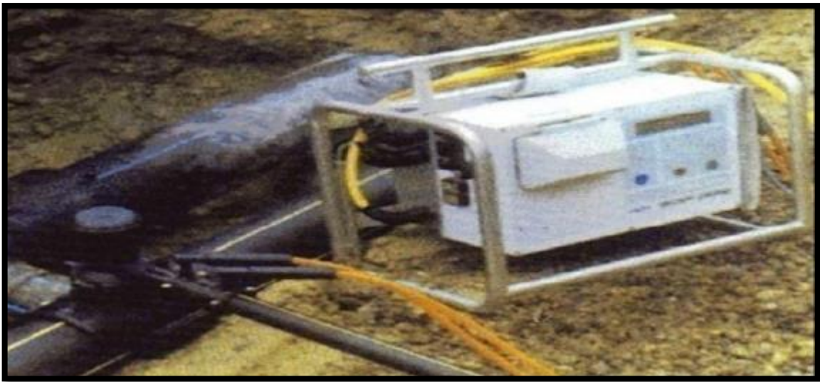
Figure VI. 5: Raccordement par accessoires électro-soudable.
