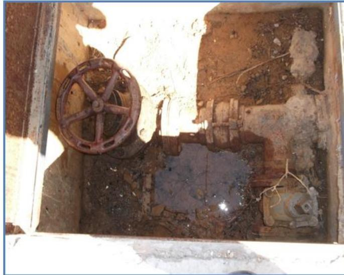
**Figure IV.11:** Dégradation de la vanne à la sortie du réservoir 200 m<sup>3</sup>
