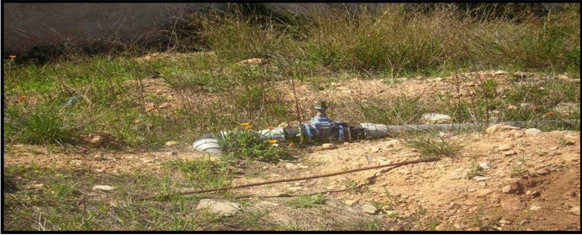
Figure III.2. Conduite en pvc 160mm (DREMOULEY SLISSEN 2023)
