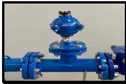
Figure VI.11 : Ventouse (Source : https://www.interhydro.fr/details-ventouses+simple+doubles+ou+triples+fonctions-78.html )
