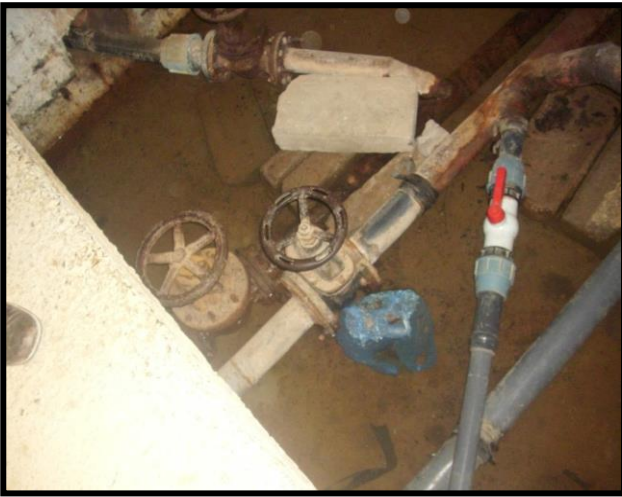
Figure III.7. Chambre des vannes remplie d'eau (DRE MOULEY SLISSEN 2023)
