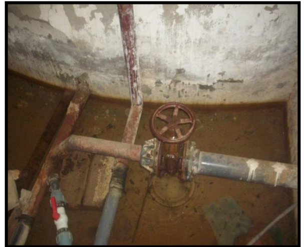
Figure III.7. Chambre des vannes remplie d'eau (DRE MOULEY SLISSEN 2023)
