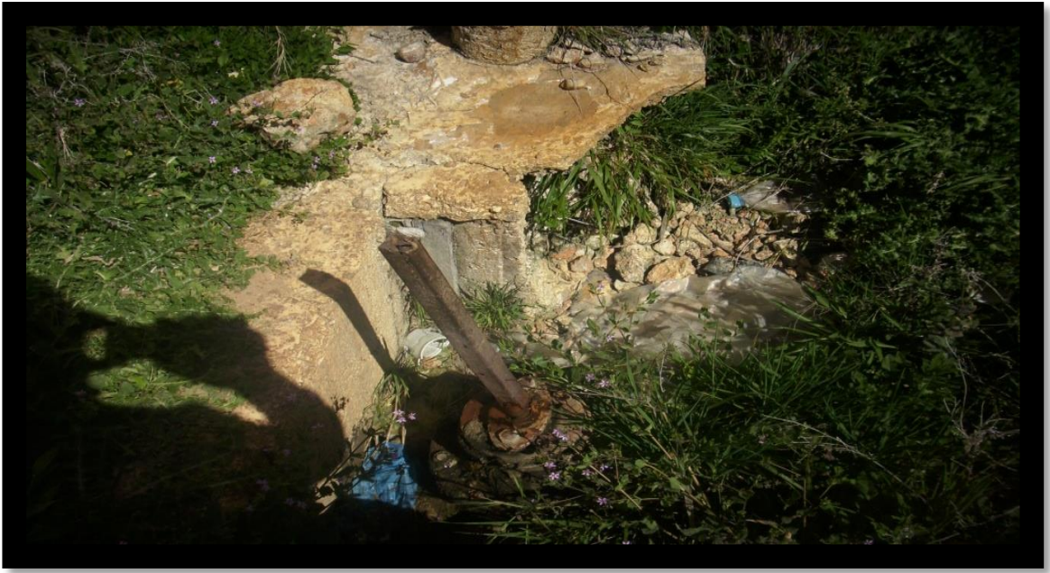
Figure III.6. Vanne de sectionnement pour distribution sans protection (DRE MOULEY SLISSEN 2023)
