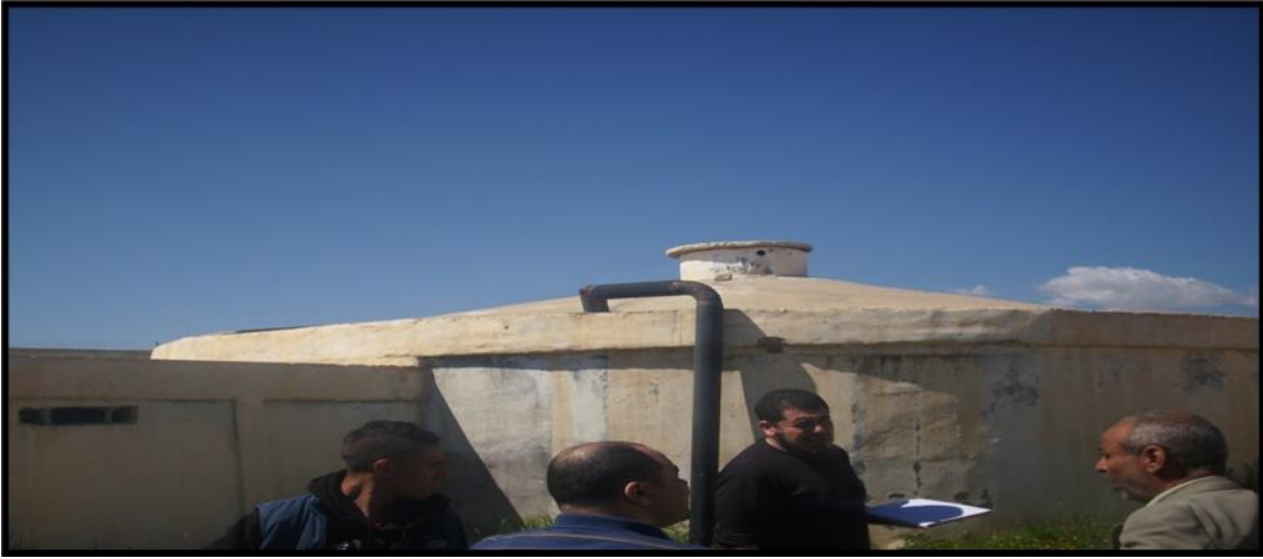
Figure III.4. Réservoir semi-enterrée de capacité de 250 m 3 (DRE MOULEY SLISSEN 2023)
