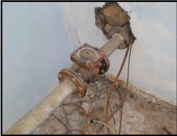
Fig III.7. robinet vanne 90mm (DRE MOULEY SLISSEN 2023)
