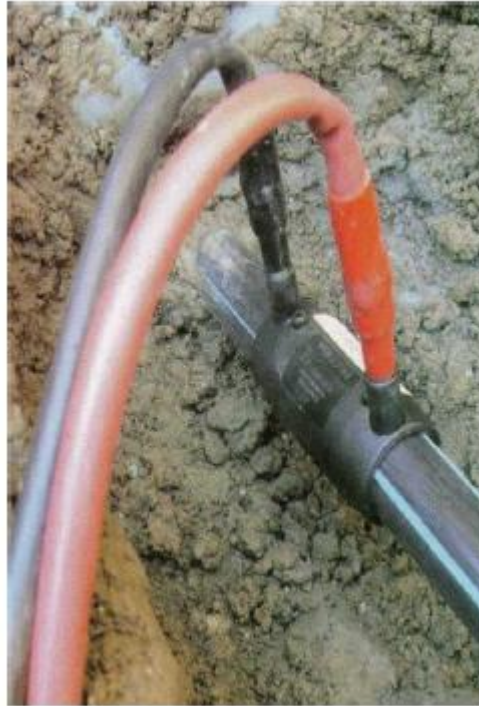
Figure IV. 2: Les moyens de raccords électro soudables
