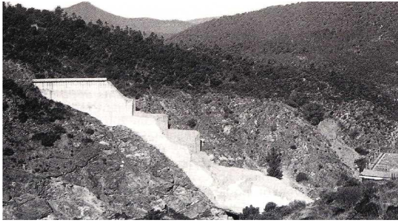
Figure II.3 : État de barrage Malpasset après la défaillance (Anderson et al, 1998).
