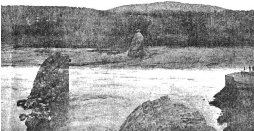
Figure II.2 : État de barrage d'Austin TX à l'état de Texas après la défaillance par glissement (Anderson et al , 1998).
