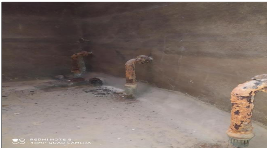
Figure IV.4 : Conduites de distribution et crépines
