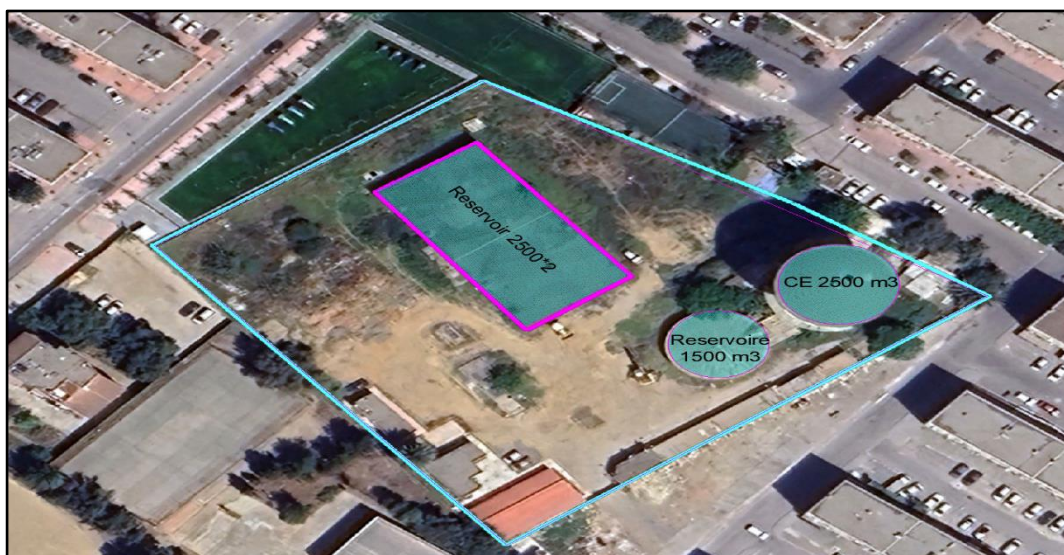
Figure IV.2 : Image satellitaire de la station de distribution
