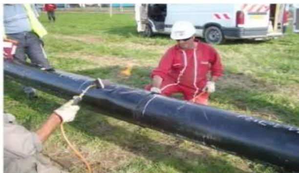
**Figure VII.21:** Protection passive par application d'un revêtement en polyéthylène (site SCRIBD)
