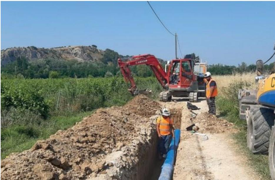
**Figure VIII.2 :** Exemple de réalisation d'un tranché d'eau potable. (La revue EIN juillet 2022)
