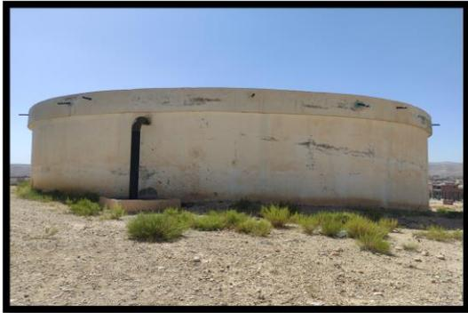
a)réservoir semi enterrée 3000m<sup>3</sup>
