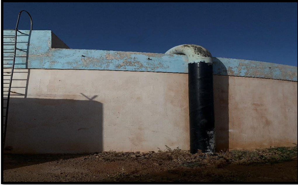
Figure IV-11 : Conduite de départ du réservoir 3000 m 3
