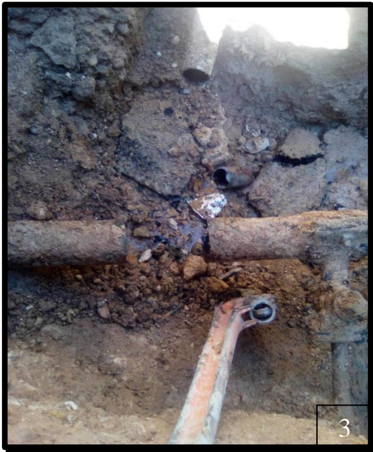
Figure III-2 : Etat physique des conduites (ADE Sebdou 2023)
