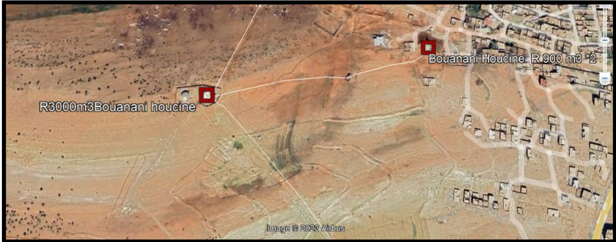
Figure I-5 : Image satellitaire des réservoirs d'alimentation en eau potable de la ville de Sebdu (ADE Sebdu)
