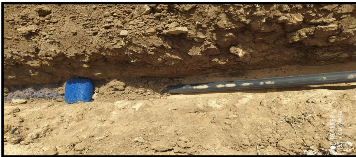
Figure VI-2: Pose des canalisations en tranchée ouverte.
