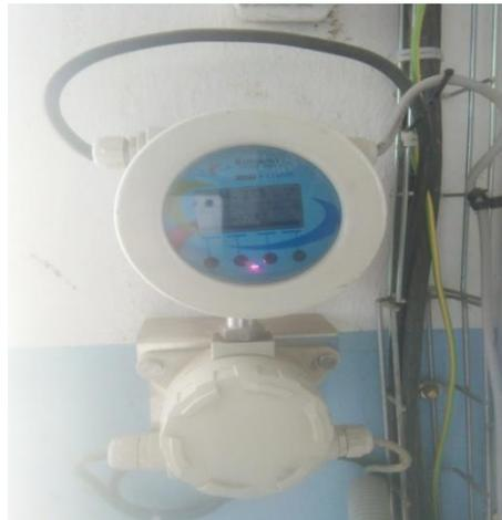
**Figure III. 15 :** Débitmètre électromagnétique
