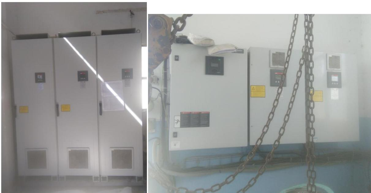
**Figure III. 25 :** armoires de compensation de l'énergie réactive de la SP1 et la SP3
