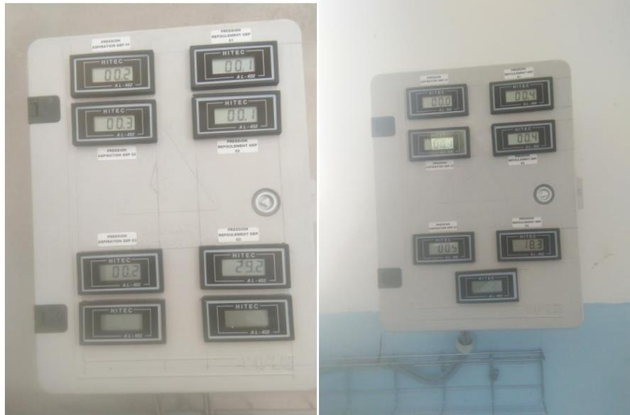
**Figure III. 24 :** Armoire affichant des pressions mesurées par les capteurs
