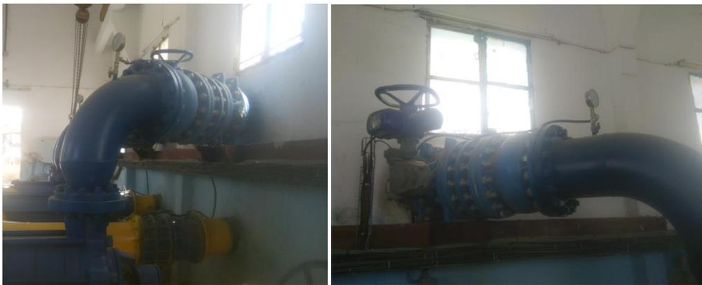
**Figure III. 9 :** Conduite de refoulement individuelle (coude + manomètre + clapet + joint de démontage + vanne motorisé) de la SP2 et la SP3
