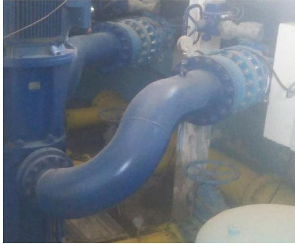
**Figure III. 8 :** Conduite de refoulement individuelle (coude + manomètre + clapet + joint de démontage + vanne motorisé) de la SP1
