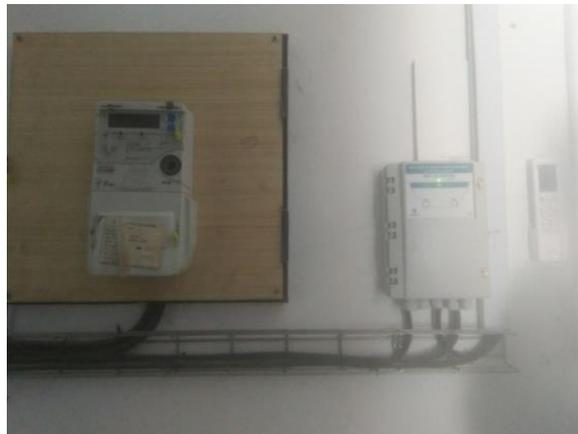
**Figure III. 18 :** Un compteur de SONELGAZ et un détecteur de défaut ampère métrique
