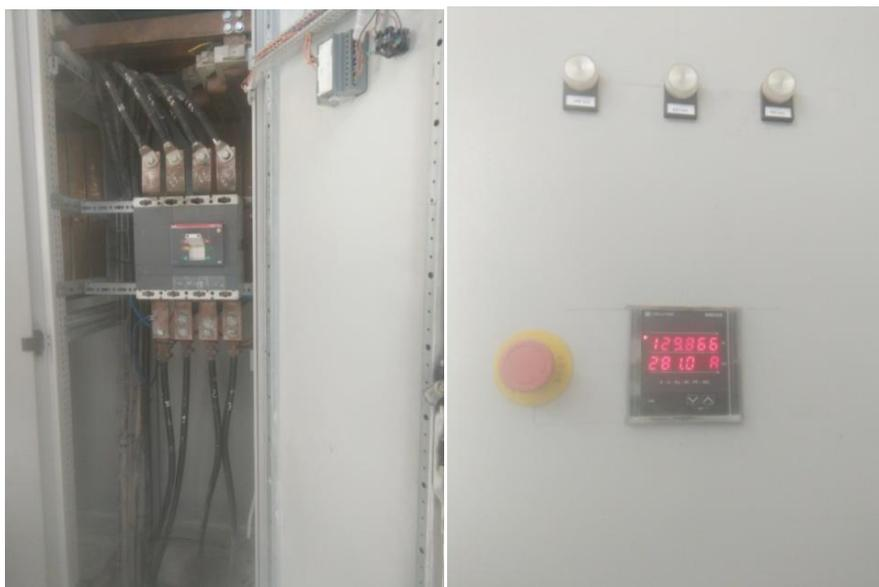
Figure III. 20 : vue extérieure et intérieure de l'armoire du disjoncteur principale
