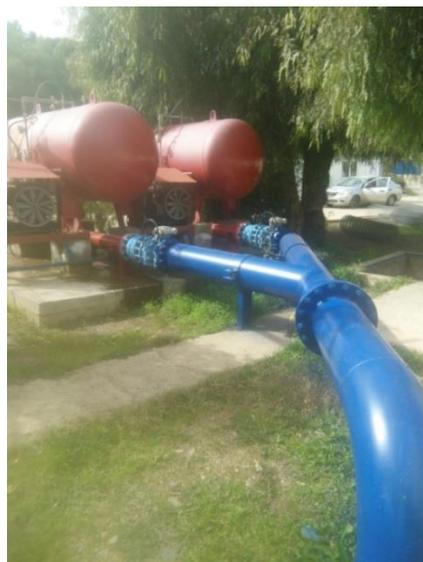
**Figure III. 11 :** Les deux réservoir anti bélier de la SP1
