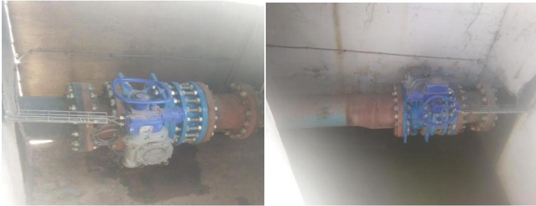
**Figure III. 7 :** Joint de démontage et vanne motorisé de la conduite de refoulement collective de la SP1 et la SP3
