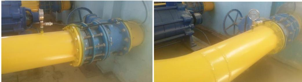
Figure III. 6 : Conduite d'aspiration individuelle de la SP2 et la SP3
