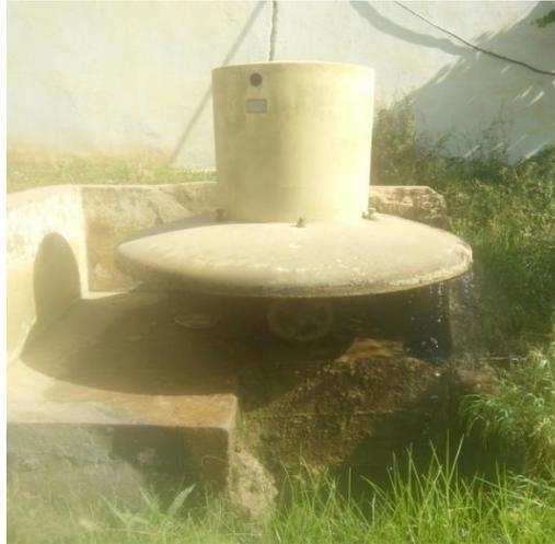
**Figure III. 10 :** Soupape de décharge de la SP1
