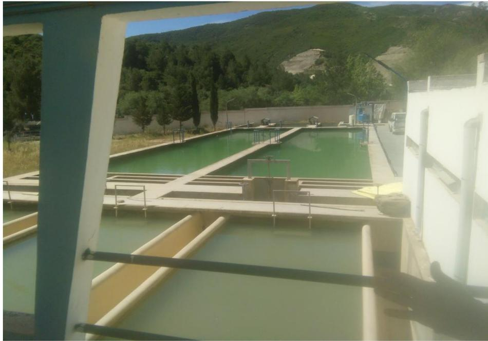
**Figure I. 14 :** Chambre de mélange + flocculateur, 2 décanteurs et 3 filtres à sable
