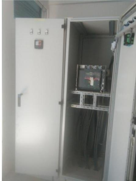
**Figure III. 17 :** Deux cellules de protection générale (clpg)
