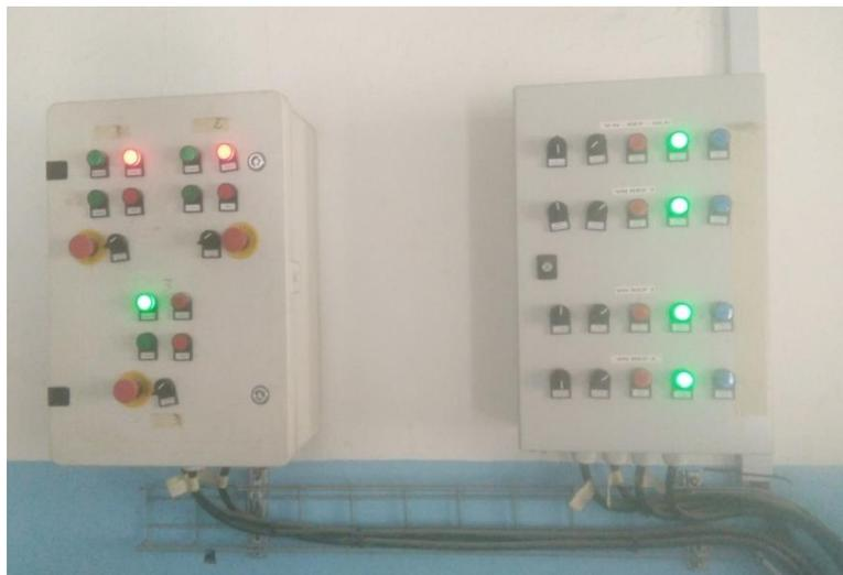
Figure III. 23 : Armoires de commandes des groupes électropompes et des vannes de la SP1
