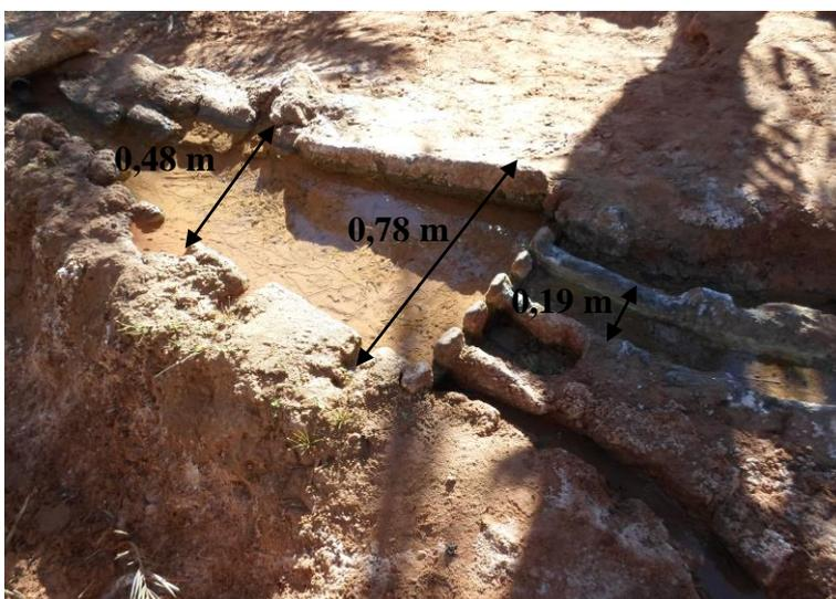
**Fig.3.7. Kasria tertiaire de la foggara d'Irsan (2013)**
