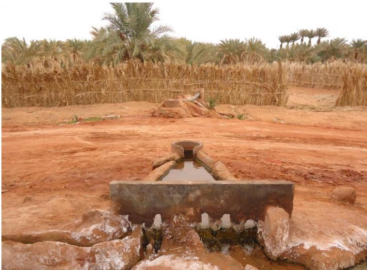
**Fig.3.11. Tube en U de la foggara d'Irsan à l'intérieur de la Palmeraie (2013)**
