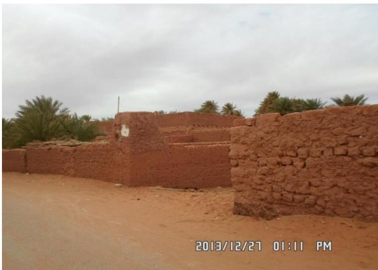
**Fig.2.15. Briques crues faites d'un mélange d'argile et de paille (2013)**
