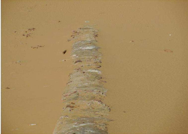
**Fig.3.8. Seguia couverte de la foggara d'Irsan (2013)**
