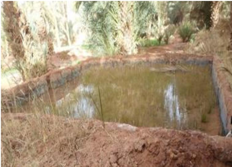
**Fig.3.15. Madjen en ciment de la foggara d'Irsan à l'intérieur de la palmeraie (2013)**
