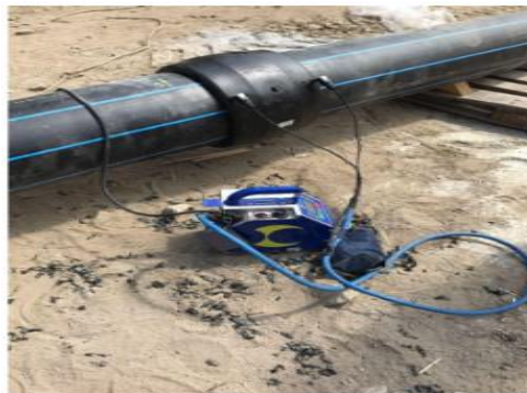
Figure V.4 : Assemblage PEHD par électro-soudage
