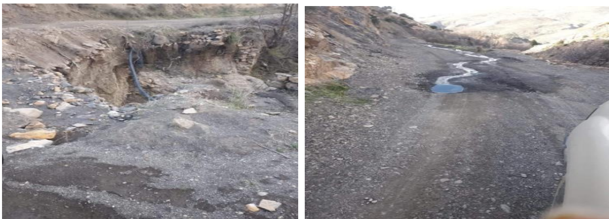
Figure IV.11: Etat physique des conduites
