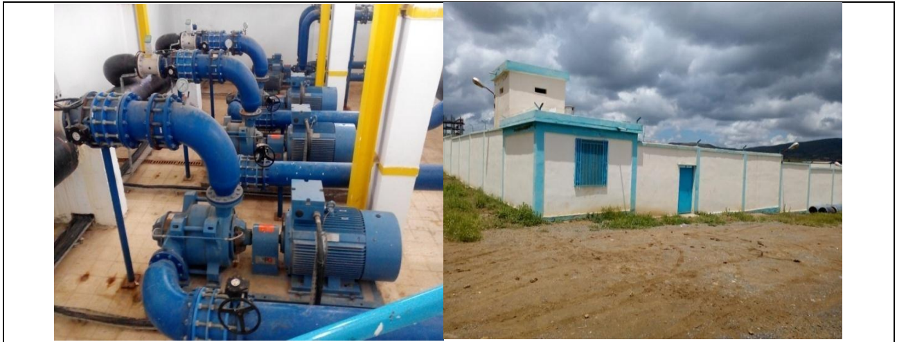
Figure IV.1 : équipements de station de pompage d'Aouin Zeraigua
