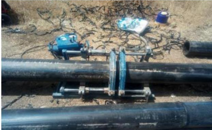
Figure V.3 : Assemblage Bout à bout
