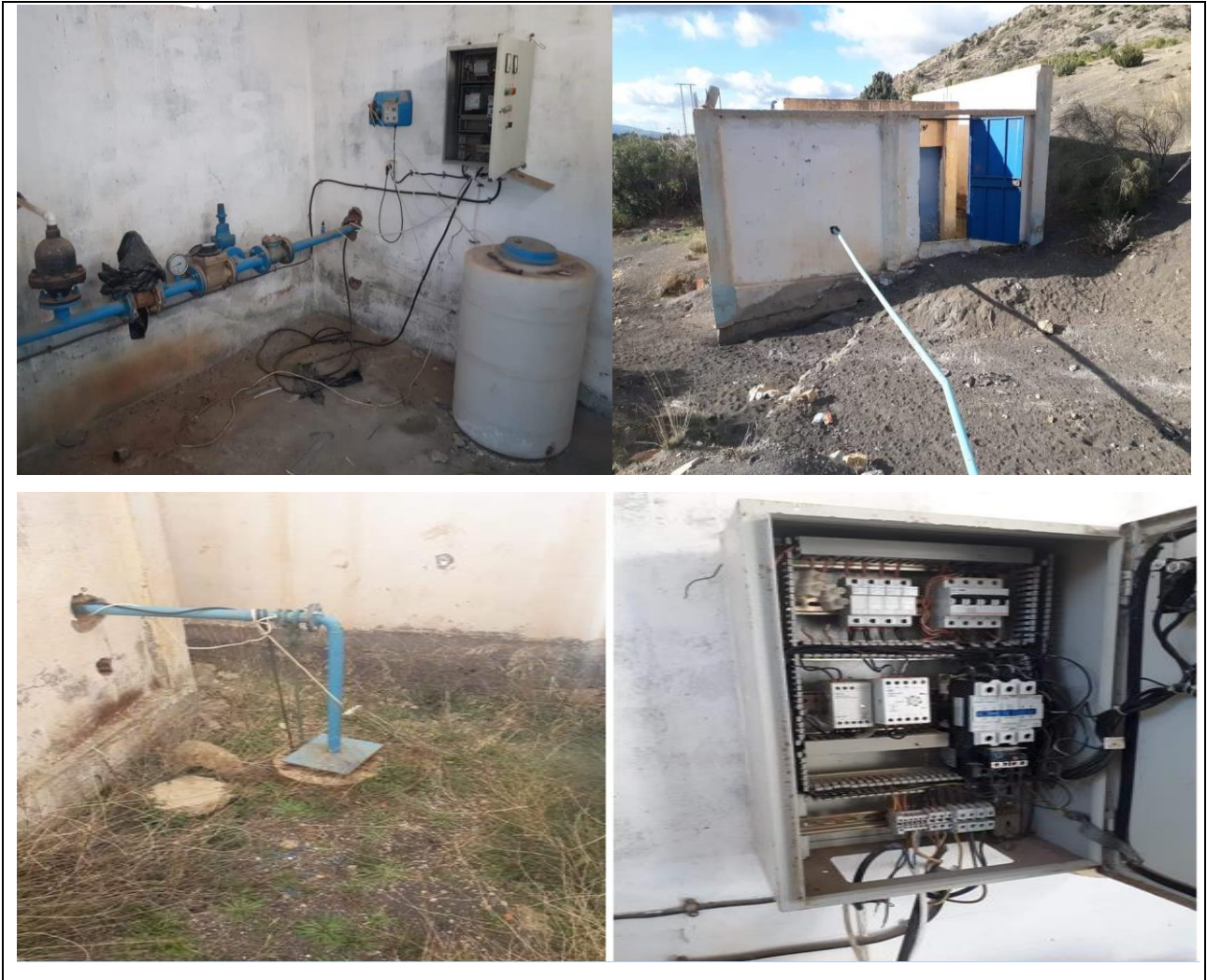
Figure IV.4 : équipements du forage d'AGHBOUL (F3)
