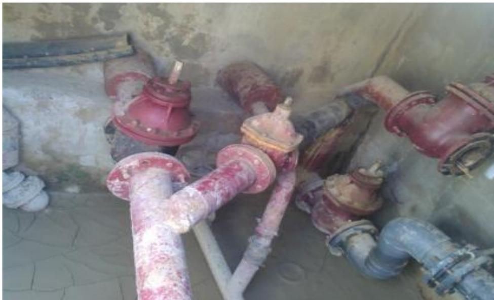
**Figure III.3** : Chambre des vannes du réservoir R 500 m<sup>3</sup> (DRE Médéa)
