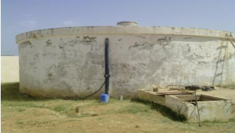
**Figure III.4 :** Réservoir R 500 m<sup>3</sup> (DRE Médéa).
