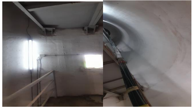
Figure III.4 : La passerelle et l'escalier dans le château d'eau 300 m 3
