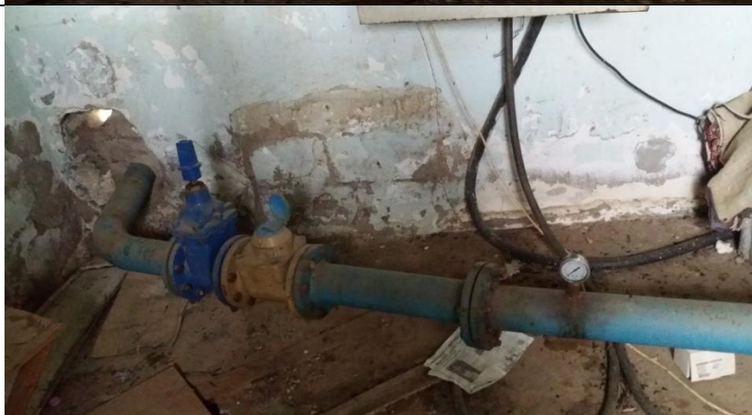
Figure III.6 : vue de l'intérieur du forage Polaille « F6 »
