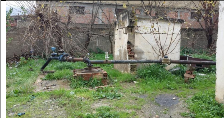
Figure III.4 : vue de l'intérieur du forage Chaaba « F5 »
