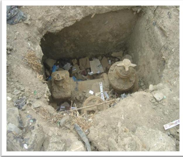
**Fig III.7. Regard et robinet vanne 90mm
