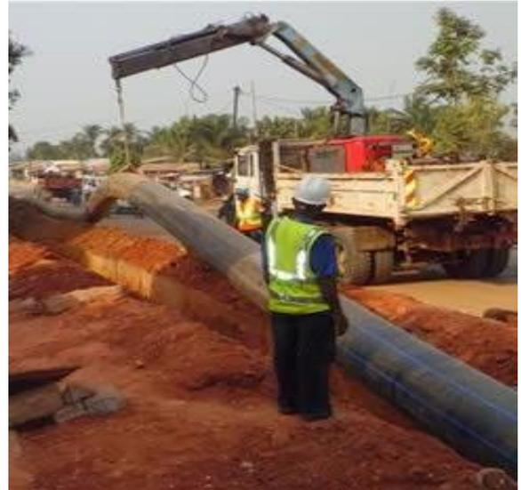
Figure VI.2 : Pose des canalisations en tranchée ouverte (Google image 2023)
