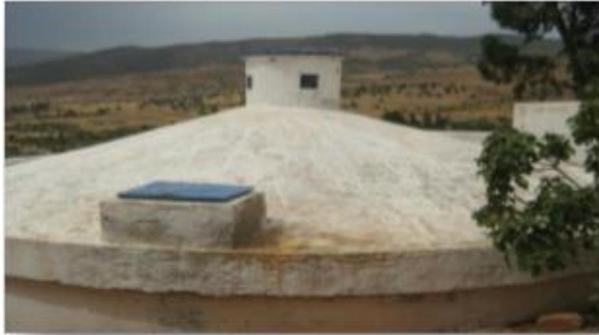
Fig III.4. Réservoir semi-enterrée de capacité de 300 m<sup>3</sup>(SEEAL2023)
