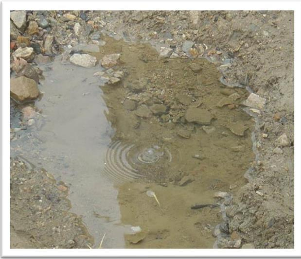
**Fig III.2. Fuite dans la conduite PVC 90mm
