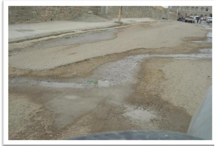
**Fig III.3. Fuite dans la conduite AMC 100mm
