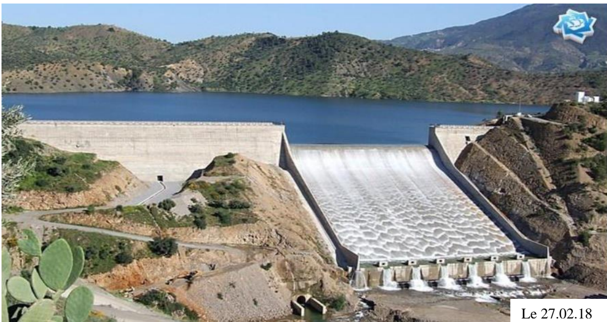
Figure I.7 : Barrage de Tichy-Haf – (Source : Agence nationale des barrages et transferts « A.N.B.T » d'Alger).
