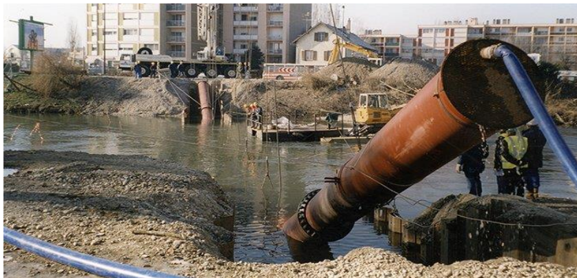
Figure VI.5 : Pose de canalisation à la traversée d'une rivière
