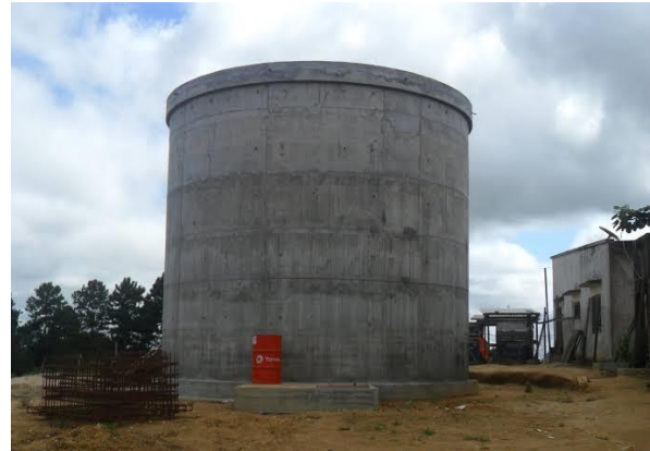
Figure IV.3 : Réservoir en béton armé
