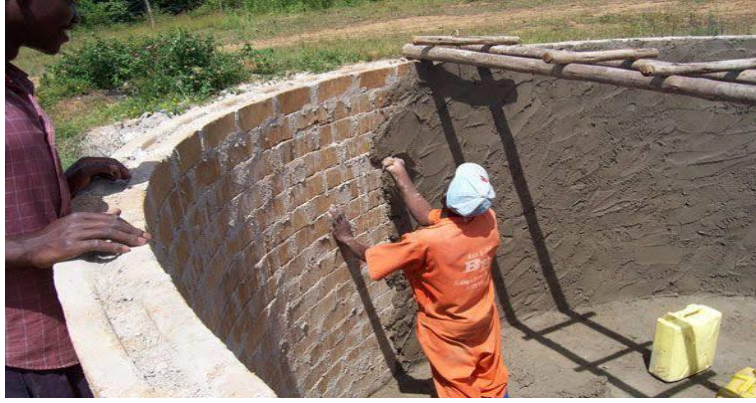
Figure IV.02 : Réservoir en maçonnerie (Source : Mazzigo Tanks)
