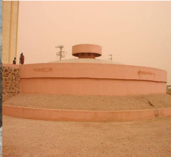
Figure IV.06 : Réservoir semi enterré
