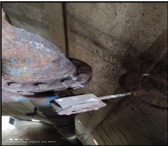
Figure III.11 : Brides et équipements corrodés Figure III.12 : Vanne en fuite et la conduite
