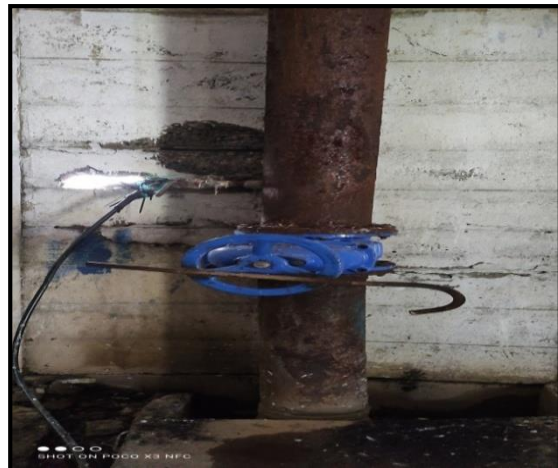
Figure III.11 : Brides et équipements corrodés Figure III.12 : Vanne en fuite et la conduite
