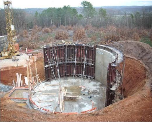
Figure IV.4 : Réservoir en béton armé (Source : CONTEC SARL)
