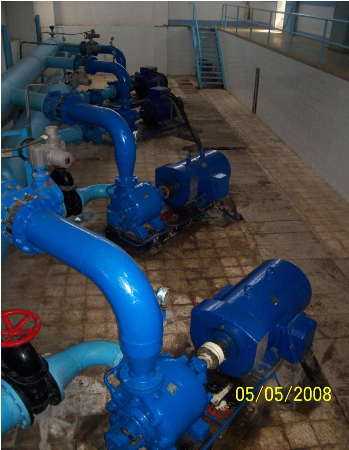
**Figure IV.5 :** Station de pompage de Beni Tamou avec deux pompes rénovées.
