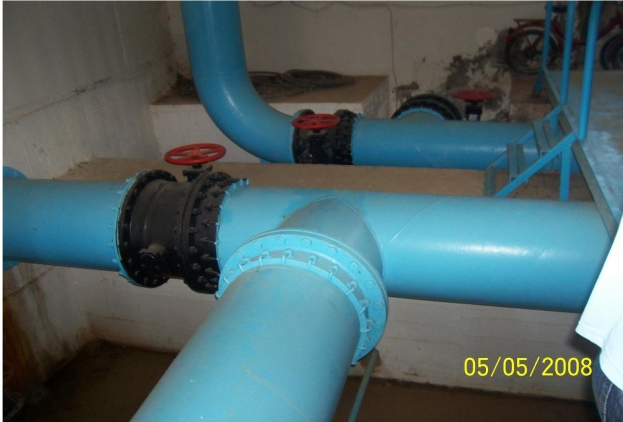
**Figure II.2 :** Conduite de départ des réservoirs d'accumulation vers la station de pompage
