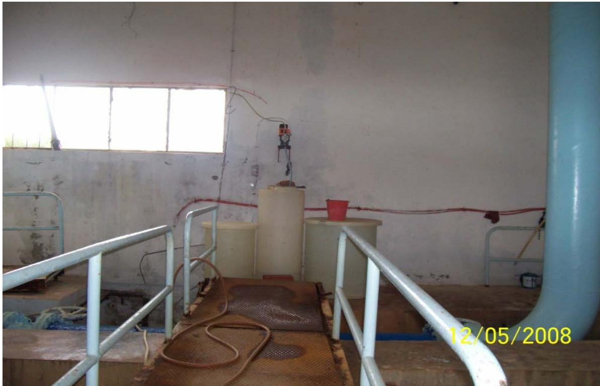
**Figure IV.3 :** Bâches de chloration
