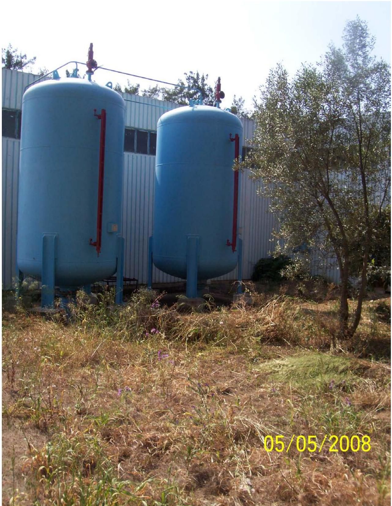
**Figure V.2** : Réservoirs d'air de la station de pompage de Beni Tamou
