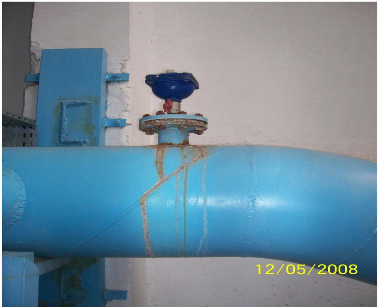
**Figure IV.16 :** Conduite de refoulement et ventouse
