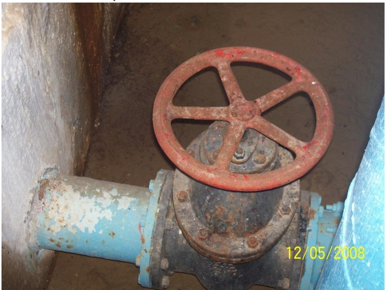
**Figure II.3 :** Conduite de vidange et robinet-vanne à fermeture lente
