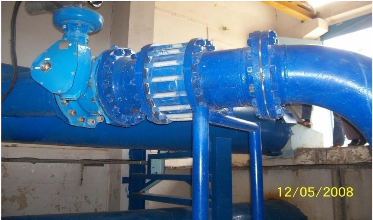
**Figure IV.11 :** Joint, Coude et clapet anti-retour
