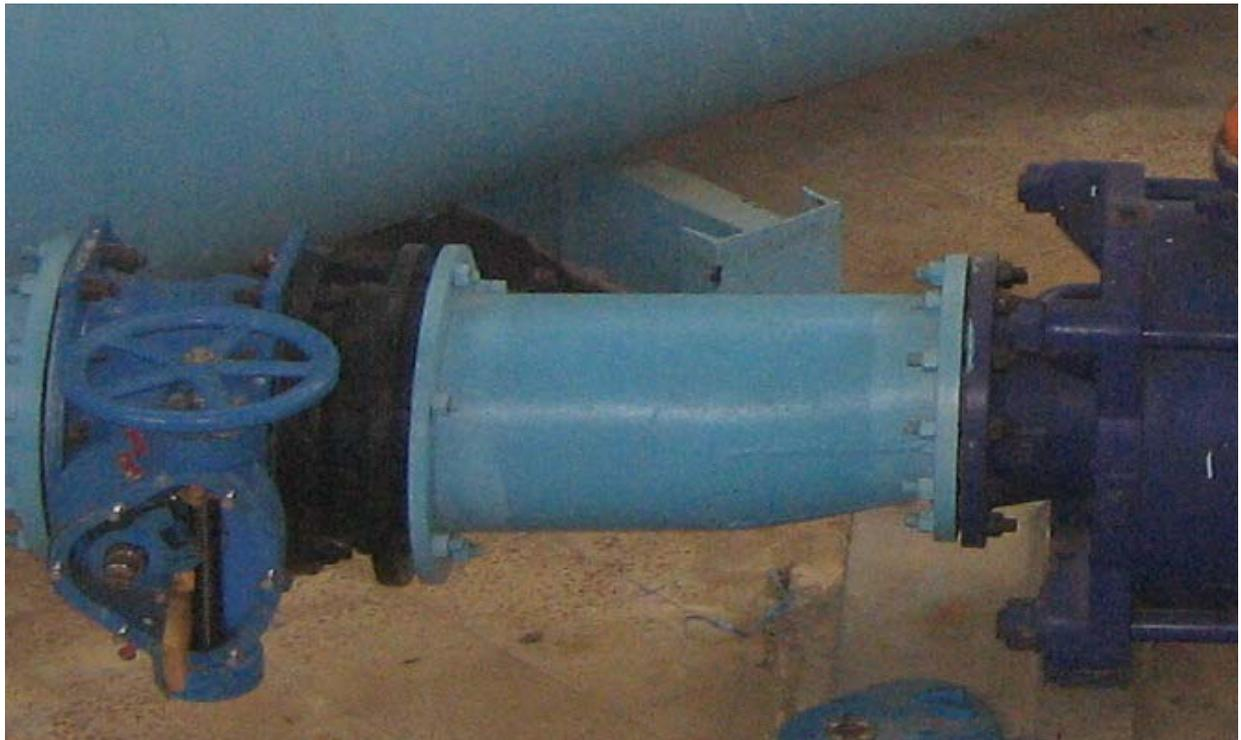
**Figure IV.18 :** Manchon et vanne type papillon, joint de démontage
