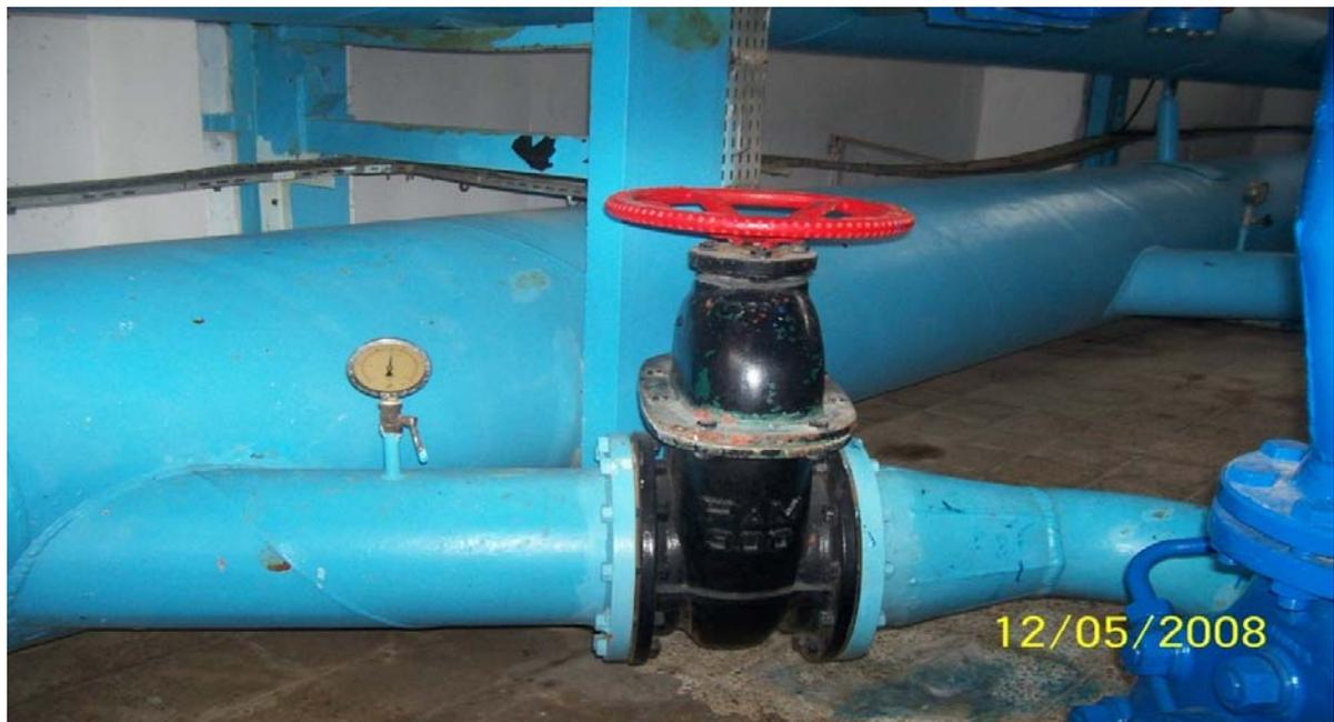
**Figure IV.14 :** Vanne d'aspiration, conduites d'aspiration collective et individuelle convergent, coude et manomètre.
