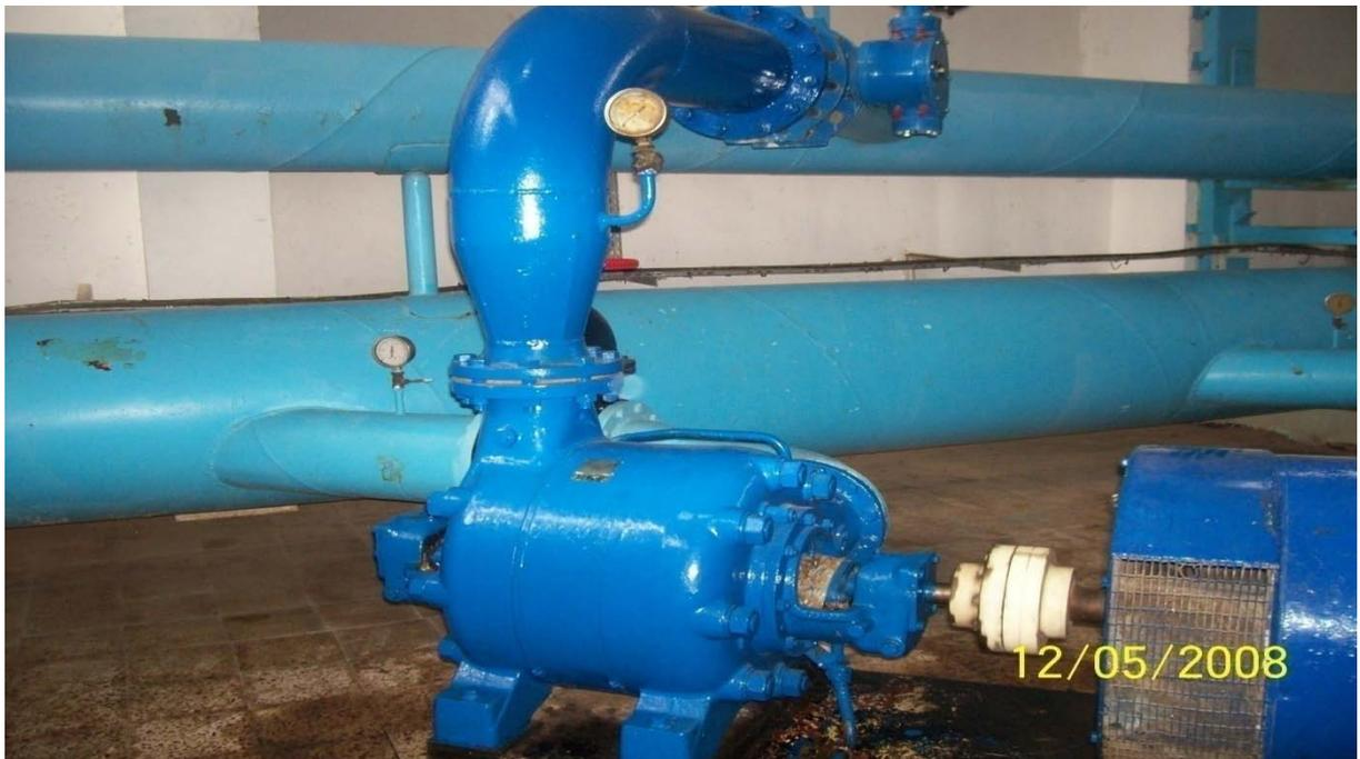
**Figure IV.15** : Pompe et moteur, divergent, coude, manomètre, conduites de refoulement individuel et collectif, clapet anti-retour
