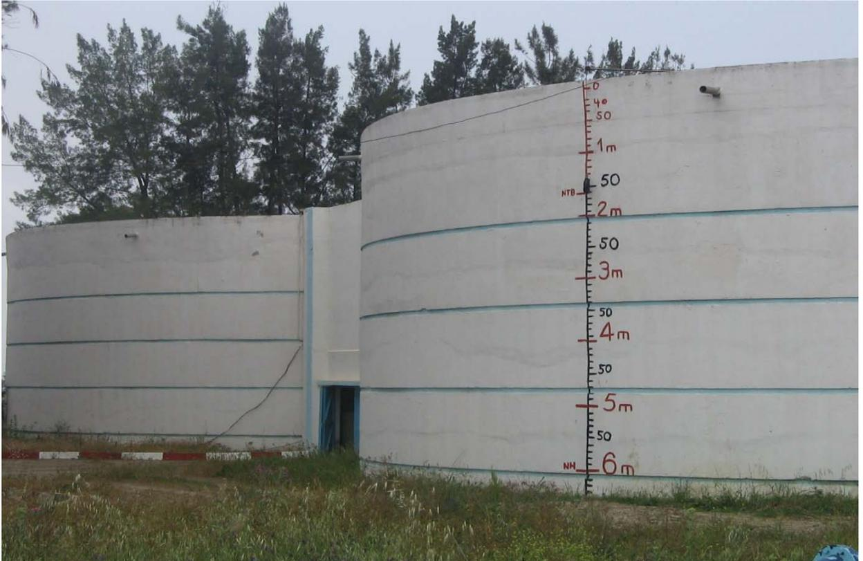
**Figure IV.1.a :** Les deux bâches d'aspiration ou d'accumulation de Beni Tamou
