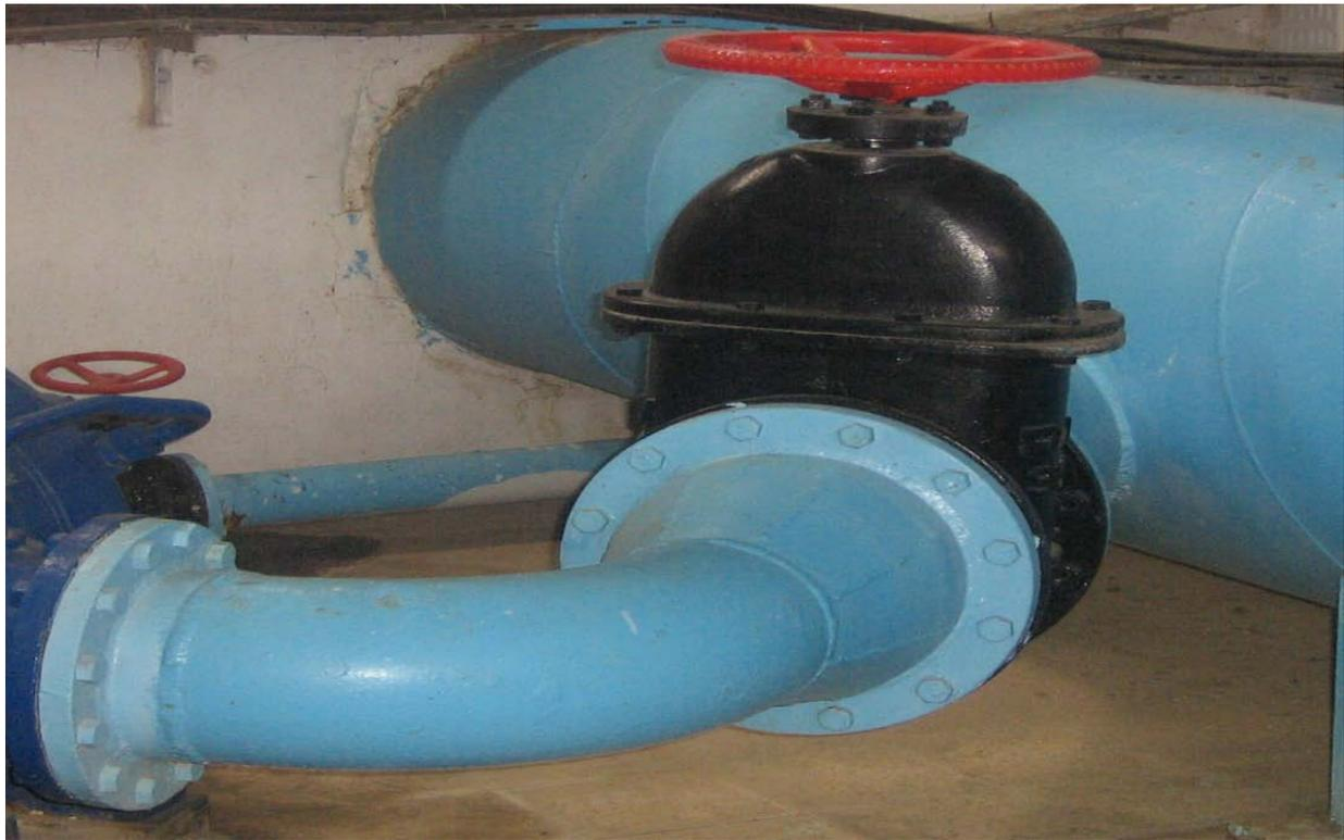
**Figure IV.17 :** Coude, vanne à opercule et convergent
