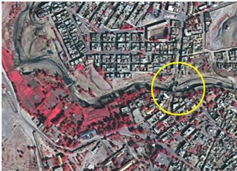
Figure II.11: Impact de l'inondation visible sur les images du satellite au niveau du pont « Mahboula » reliant les deux rives, dont une partie a été emportée par les eaux.
