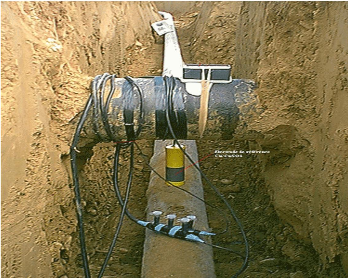
Fig. VI-8 : Schéma montre le dispositif de la protection cathodique
