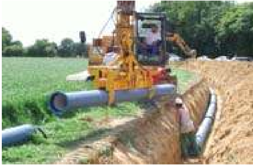
Figure VI.1.a : Pose de conduite dans un terrain ordinaire.
