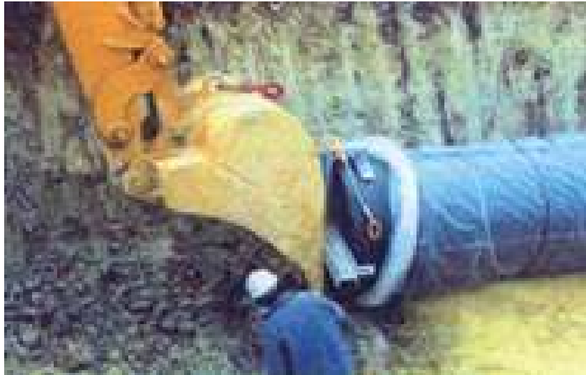
Figure VI.1.c: Pose de conduites dans un terrain agressif.
