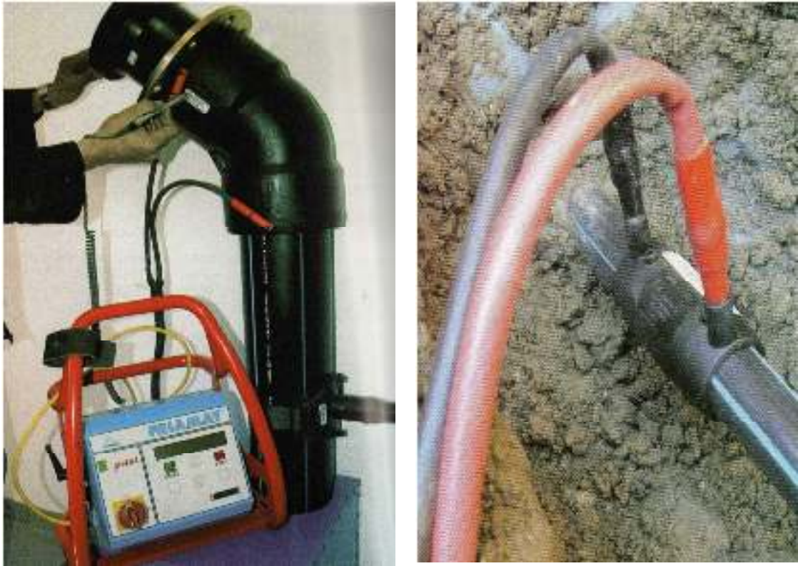
Figure VI.2 : Les moyens de raccords électro soudables
