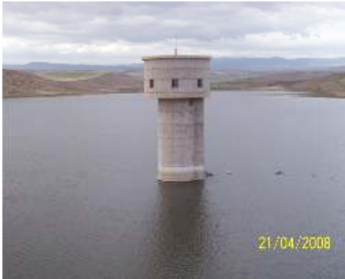
La Toure de prise de barrage sikkek (Tlemcen)
