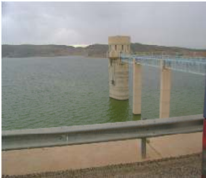
La Toure de prise de barrage Hammam boughrara (Tlemcen)
