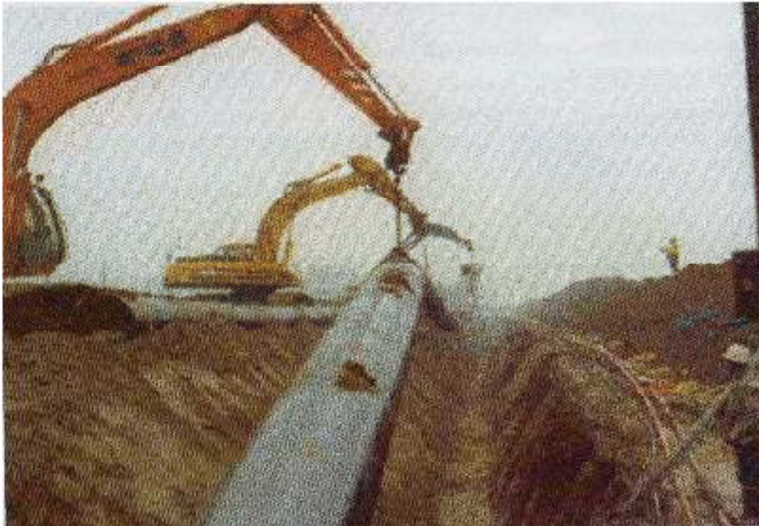
Figure N° VII.4 : pose des conduites en PE dans les tranchées
