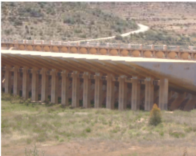
Evacuateur de crue multi godet de barrage béni bahdel (Tlemcen)
