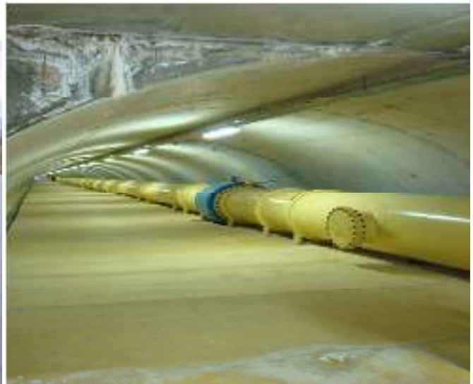
La galerie de barrage sikkek (Tlemcen)
