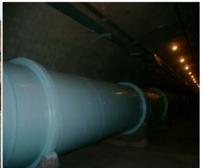
La galerie du barrage Hammam boughrara (Tlemcen)
