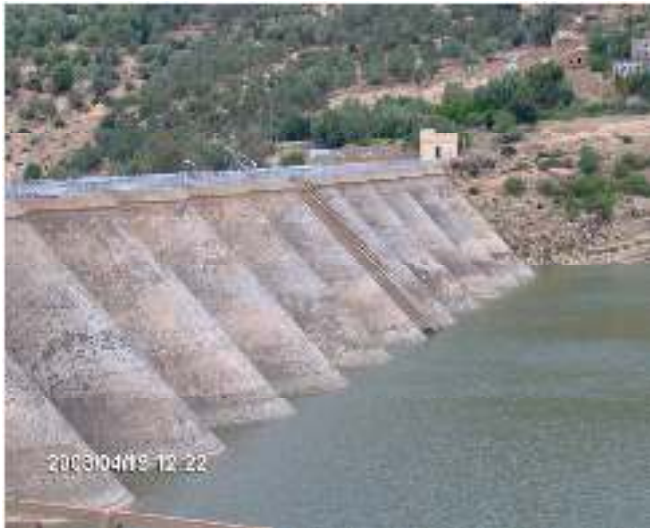
Barrage de Béni bahdel de forme multi voutes (Tlemcen)
