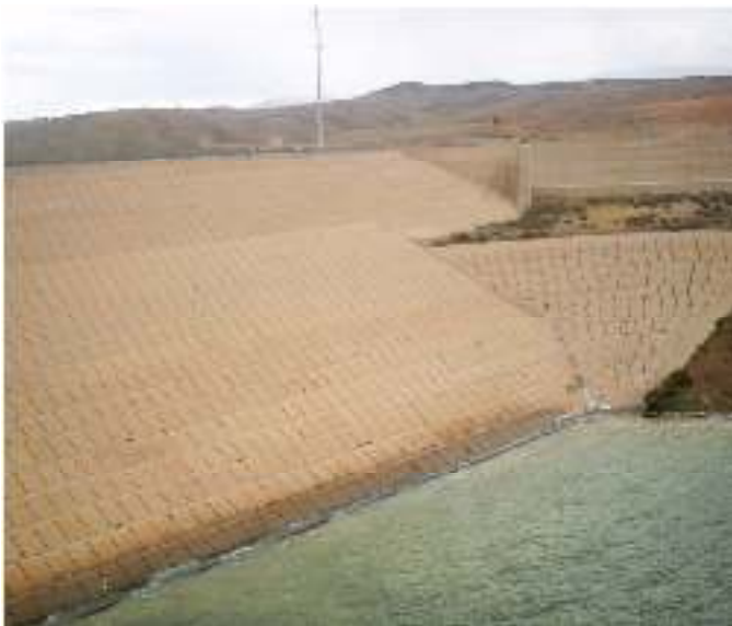
Protection de l'amont de barrage de hammam boughrara en béton (Tlemcen)
