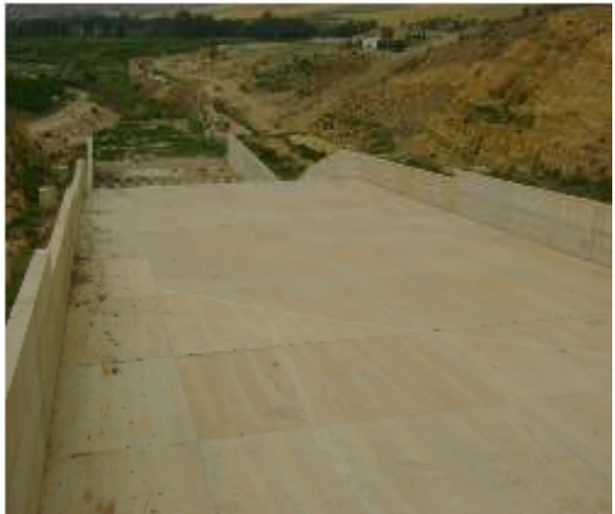
Evacuateur de crue de barrage Hammam boughrara (Tlemcen)
