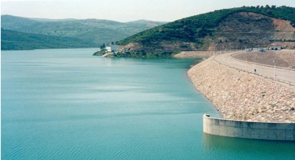
Fig. 3. Barrage de Keddara.
