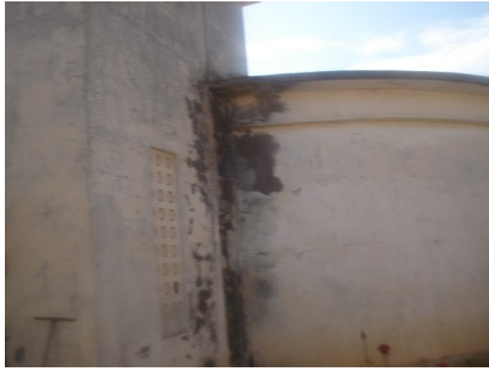
Figure N°V.5: Réservoir de 250m^3 dans la commune de Damous.
