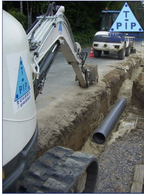
Figure N°VIII.1: Pose d'une conduite au bore d'une route
