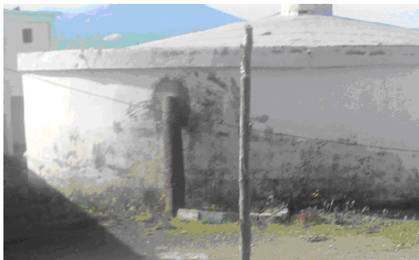
Figure N°V.4: Réservoir de 750m 3 dans la commune d'Aghbal.
