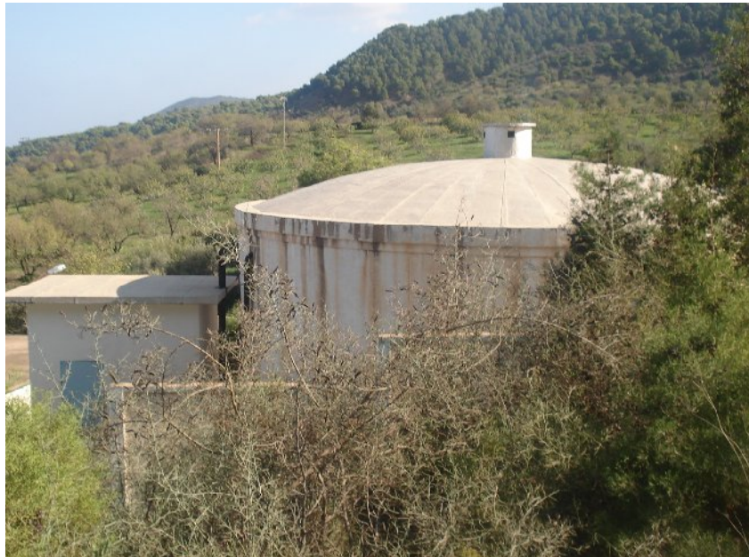
Figure N°V.3: Réservoir de 500m 3 dans la commune de Larhat
