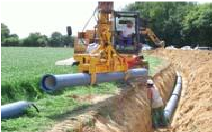
Figure VI.1.a : Pose de conduite dans un terrain ordinaire.
