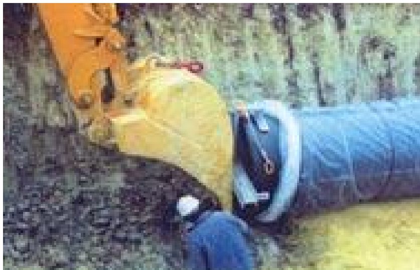
Figure VI.1.c: Pose de conduites dans un terrain agressif.
