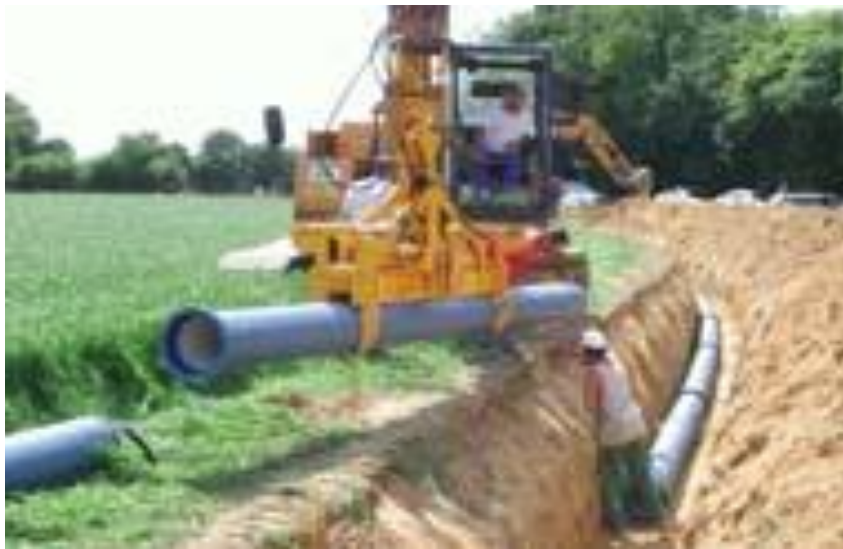
Figure VIII-1-a: Pose de conduite dans un terrain ordinaire.
