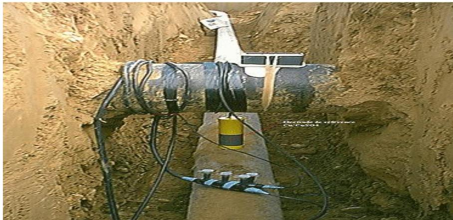
**Fig. VI-9-Schéma montre le dispositif de la protection cathodique**
