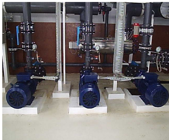
FigureVI-5: les pompes des filtres à sable
