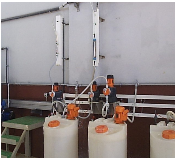
FigureVI-12: Post de préparation de produits chimiques
