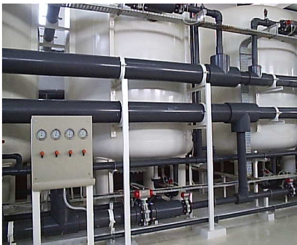
FigureVI-4 : les filtres à sable de la station
