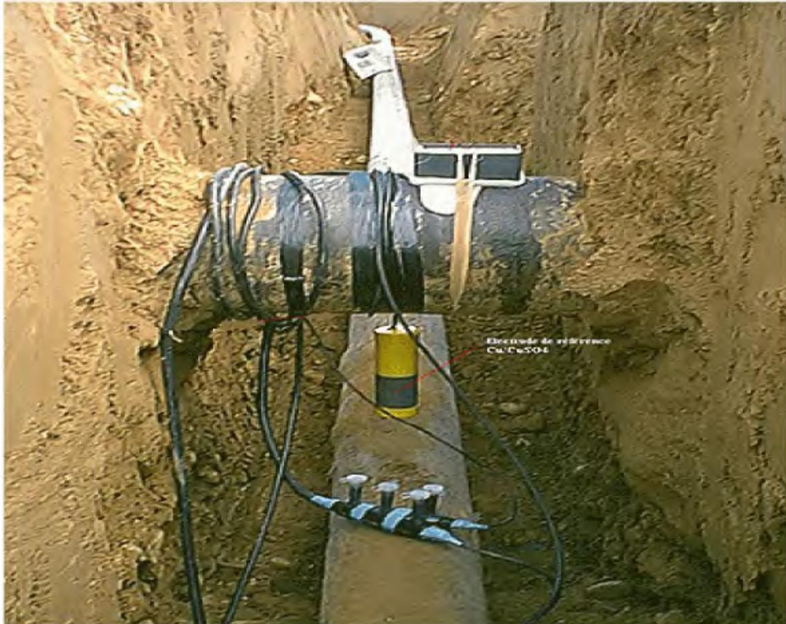
**Figure N° 05 :** Schéma montre le dispositif de la protection cathodique
