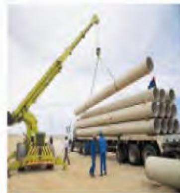
**Figure N° 07 : Conduites en PRV sur chantier**
