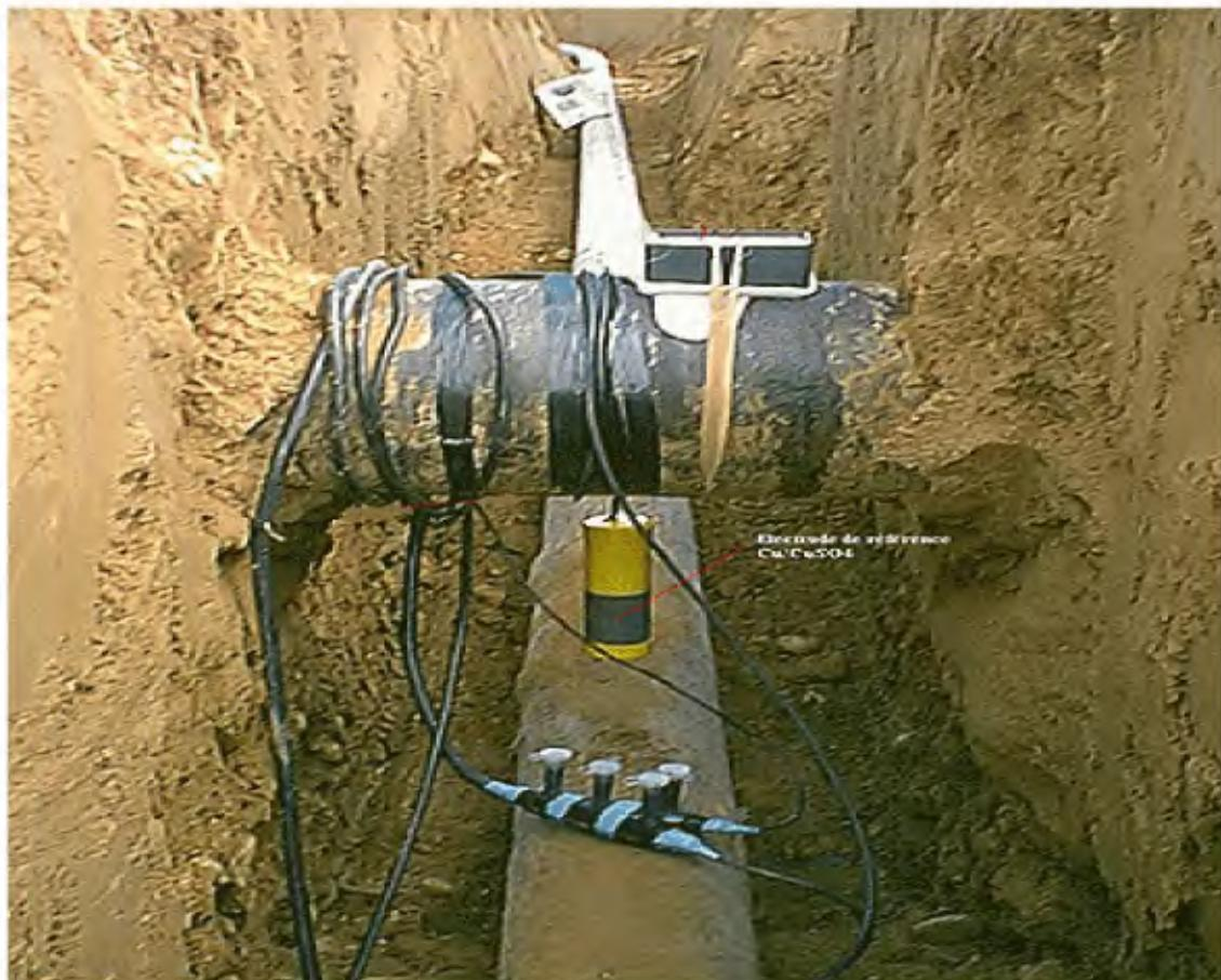
**Figure N° 05 :** Schéma montre le dispositif de la protection cathodique
