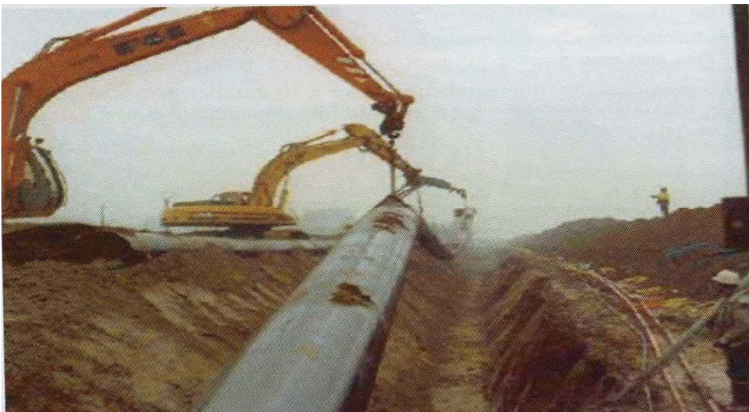
Figure N°VIII.6 : pose des conduites en PEHD dans les tranchées
