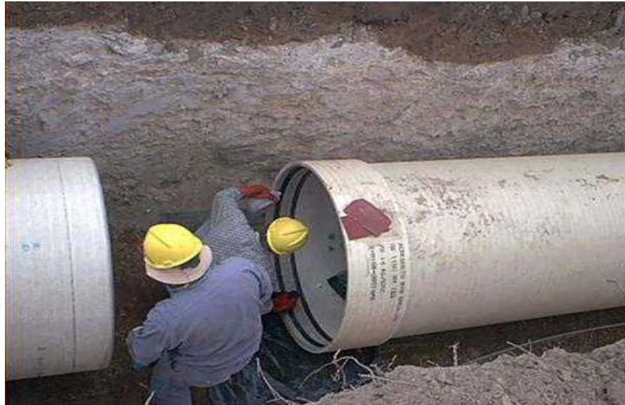
Figure. IX.6 : Lubrification du joint avant emboîtement
