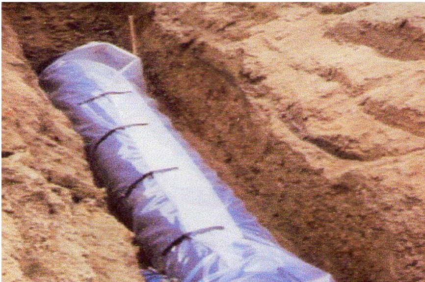
Figure VI.3 : Installations de tuyaux recouverts d'une protection en polyéthylène.
