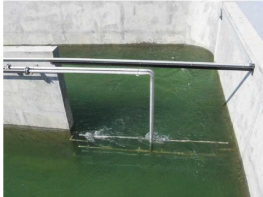
figure VII-5. Injection de l'acide sulfurique
