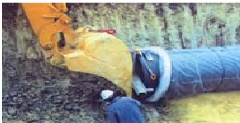
Figure VII.3. : Pose de conduites dans un terrain agressif.
