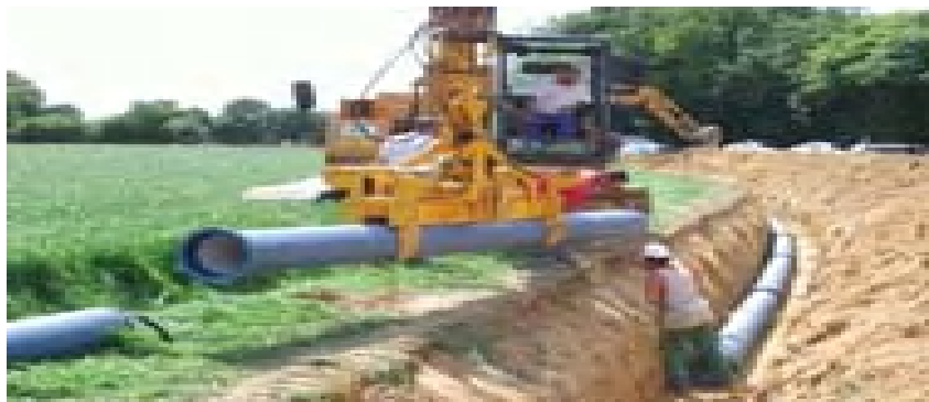
Figure VII.1. : Pose de conduite dans un terrain ordinaire.
