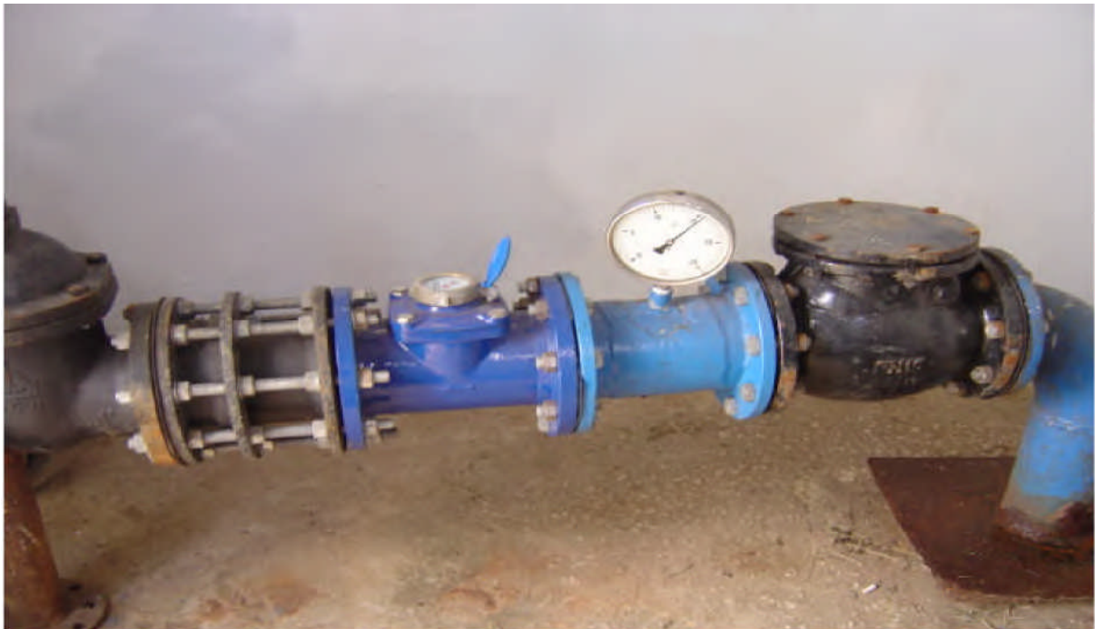
Figure N°III.2 : Forage F5 dans le bâtiment
