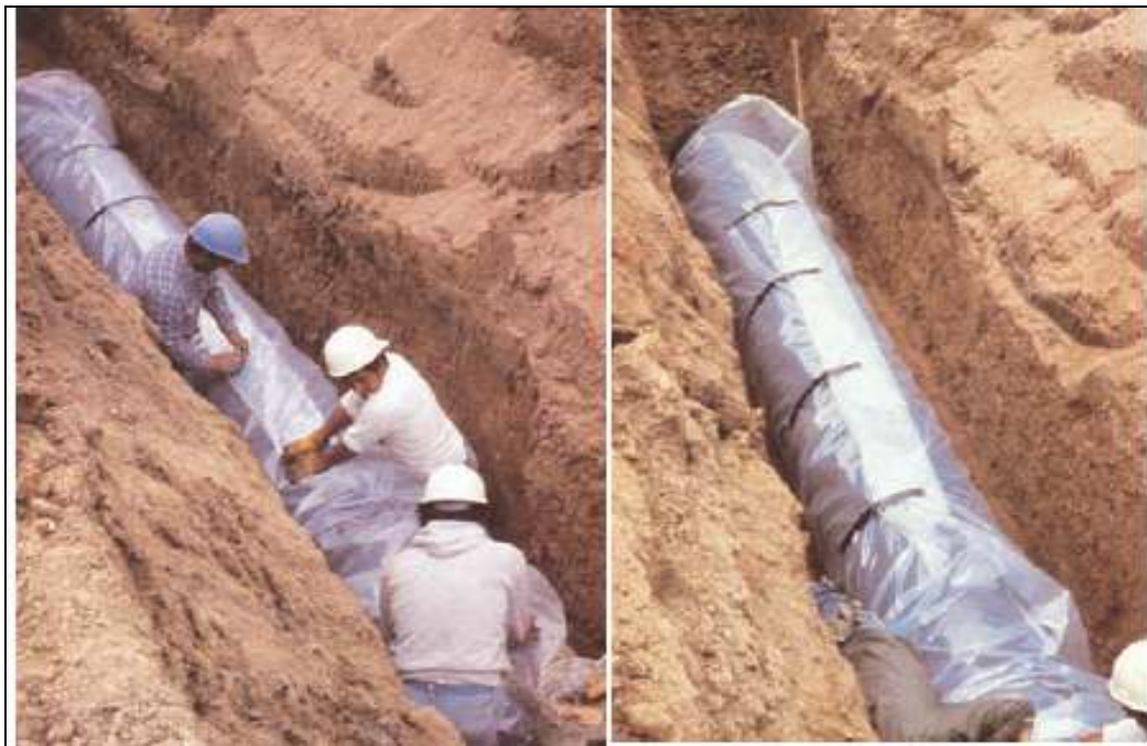
Figure VI-14 : Protection contre la corrosion extérieure avec revêtement en polyéthylène
