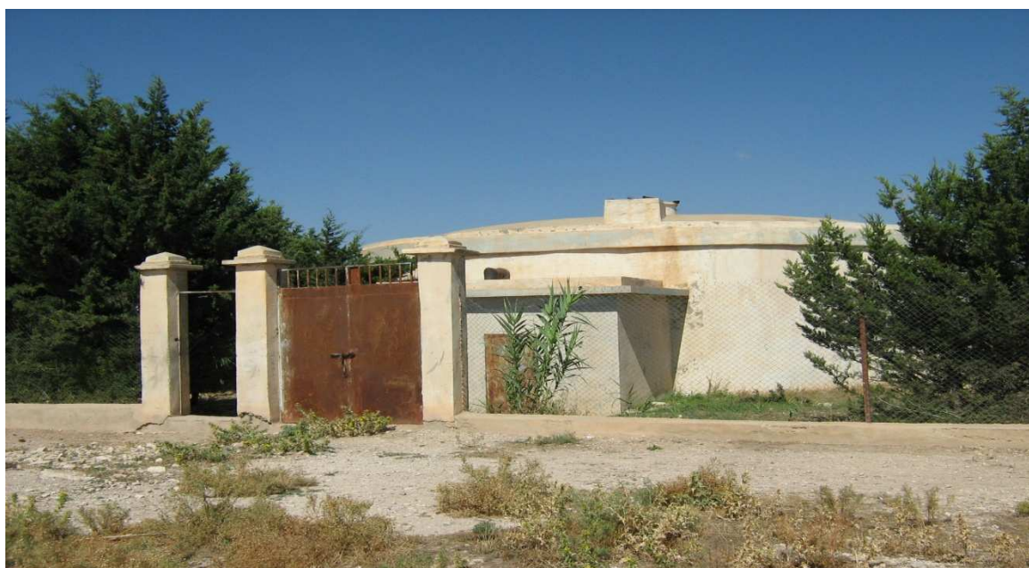
Figure II-5: Vue du Réservoir R1 (500m 3 )
