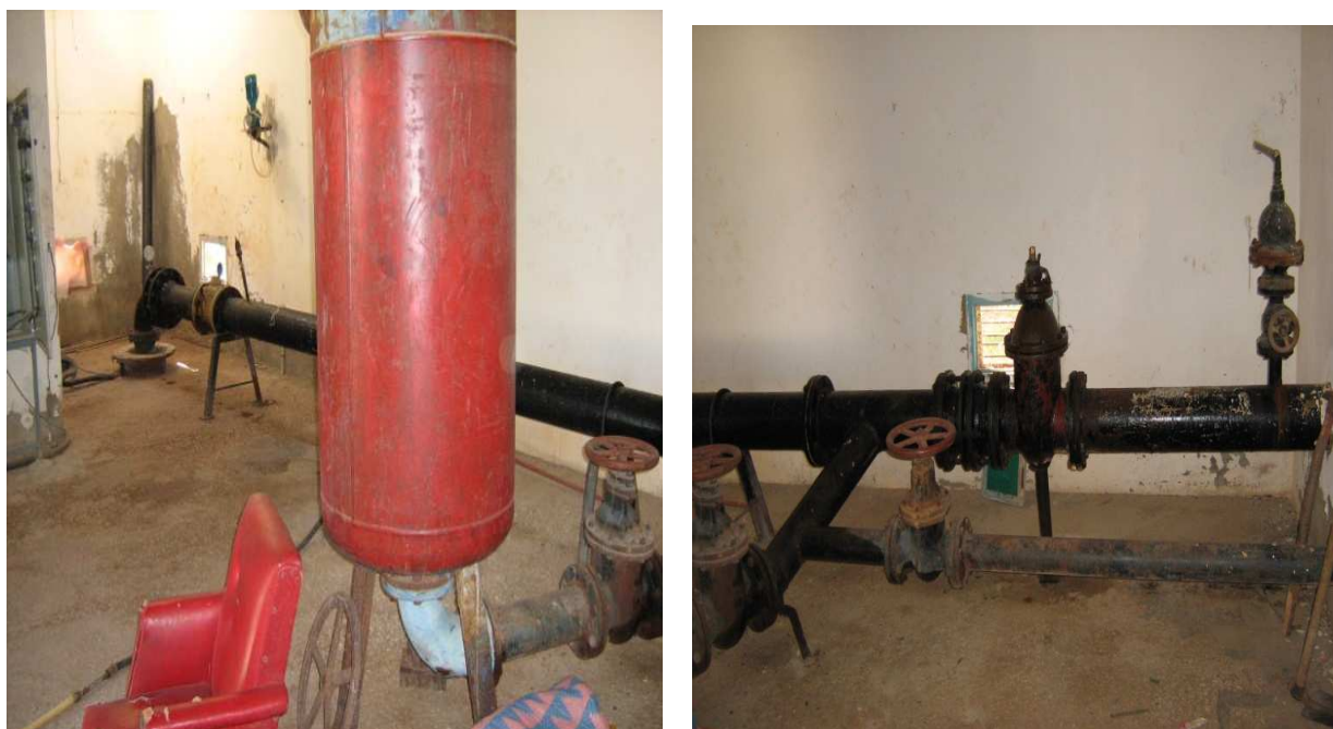
Figure II-4: Equipement du forage J8-9bis.
