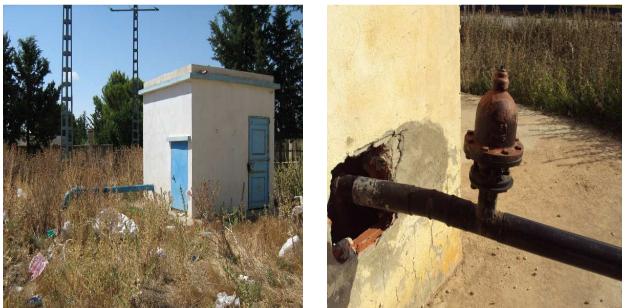
Figure II-1 : Vue du forage CH1-bis.
