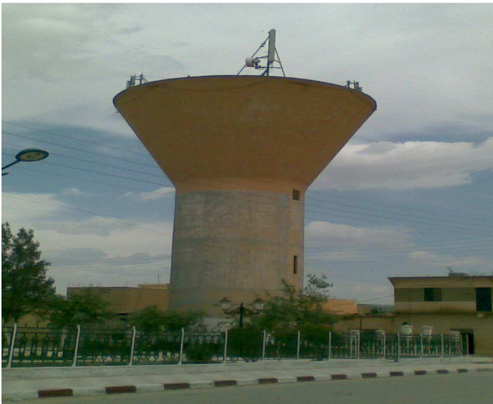
Figure II-6: Vue du Château d'eau R2 (500m 3 ).
