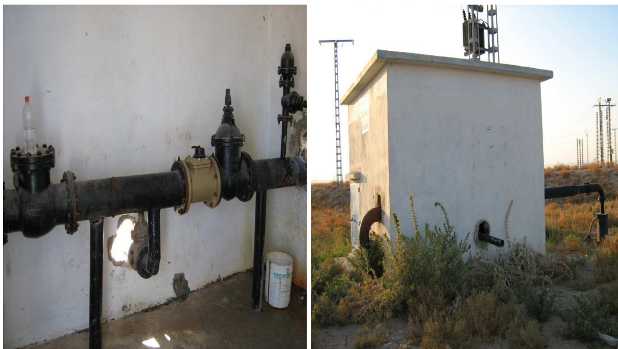
Figure II-3: Vue du forage CH5.
