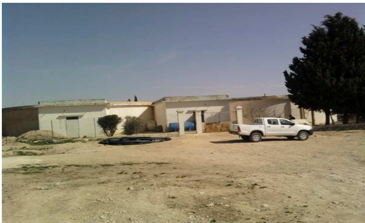
Figure II-7: Vue des Cuves jumelés R2+R3 (2X1000) m 3 .
