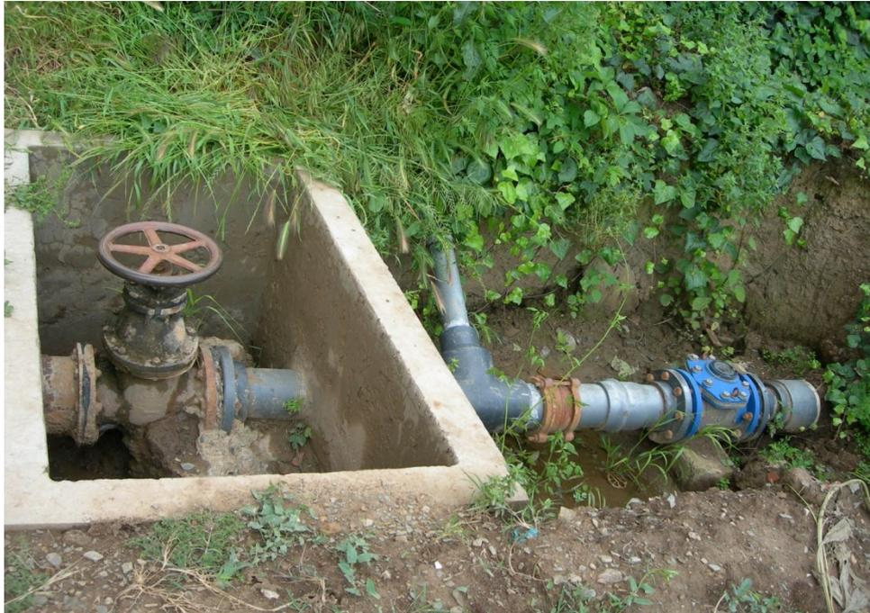
Figure II.5 : Vanne (lent fermeture) de réglage a la sortie du réservoir.
