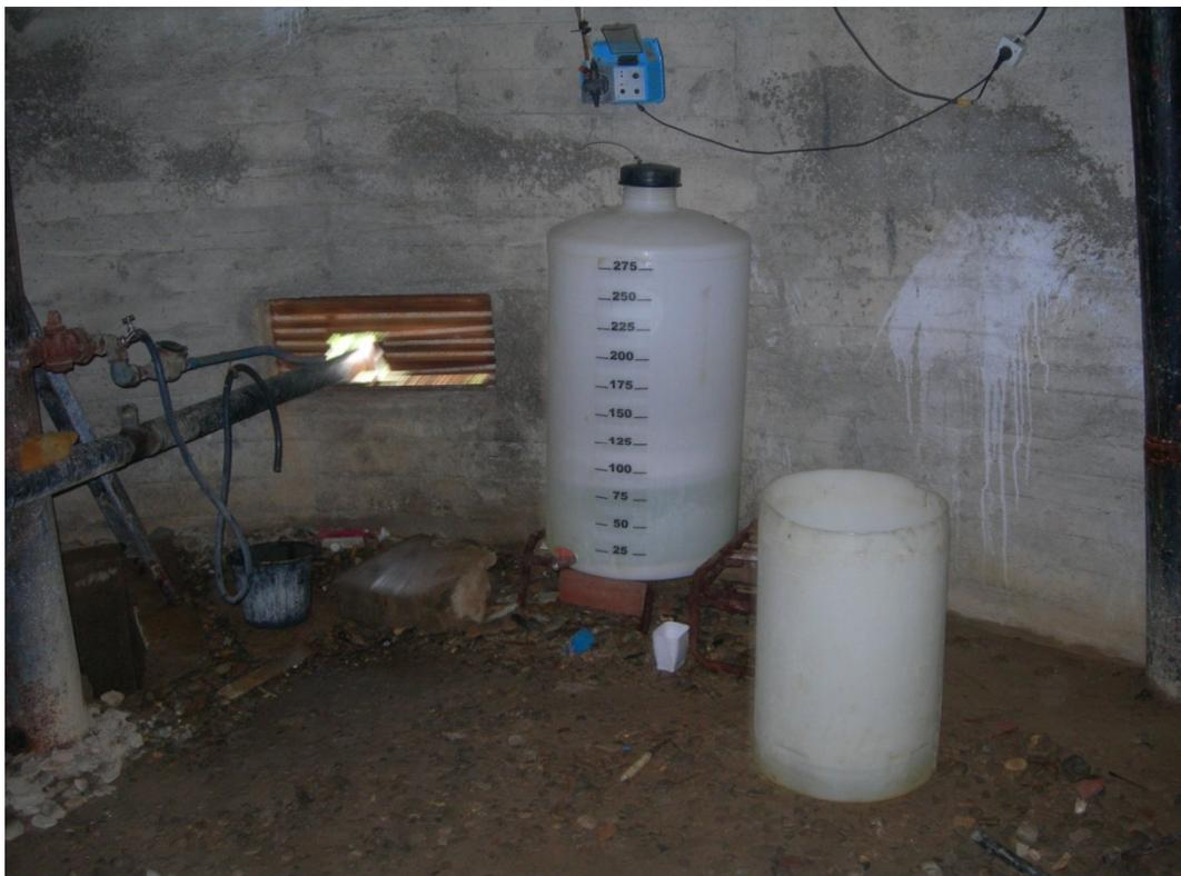
Figure II.6 : La pompe doseuse du chlore dans la chambre de manœuvre.
