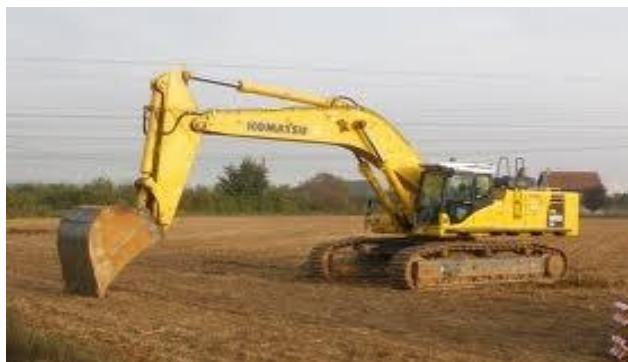
Fig. 7.1 : Pelle mécanique à chenilles
